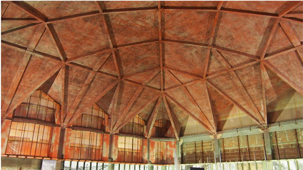
Figura 9. La volta dopo la bonifica del 2008.
