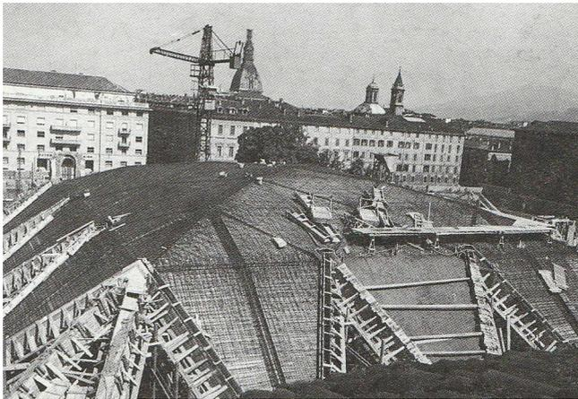
Figura 7. Foto di cantiere: fasi costruttive della volta, 1955. (da Alberto Papuzzi (a cura di), La borsa Valori di Torino. Il progetto, la sua storia, Allemandi &C., Torino 2011).
