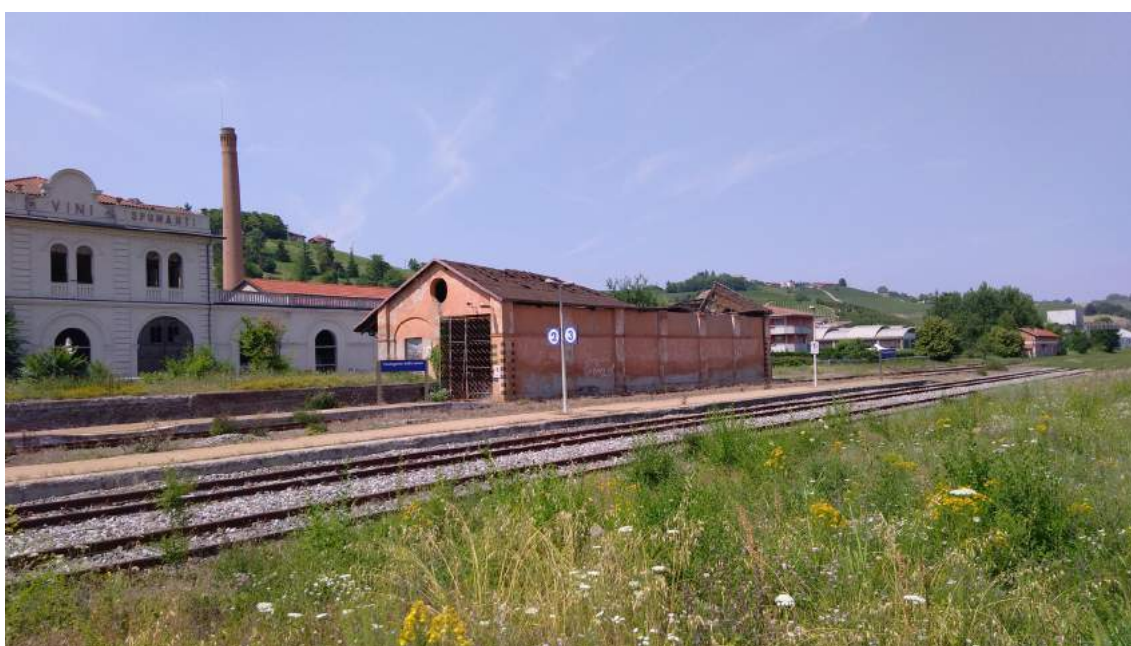
Scalo merci della stazione di Castagnole delle Lanze, fronte sud-ovest, foto dell'autore.
