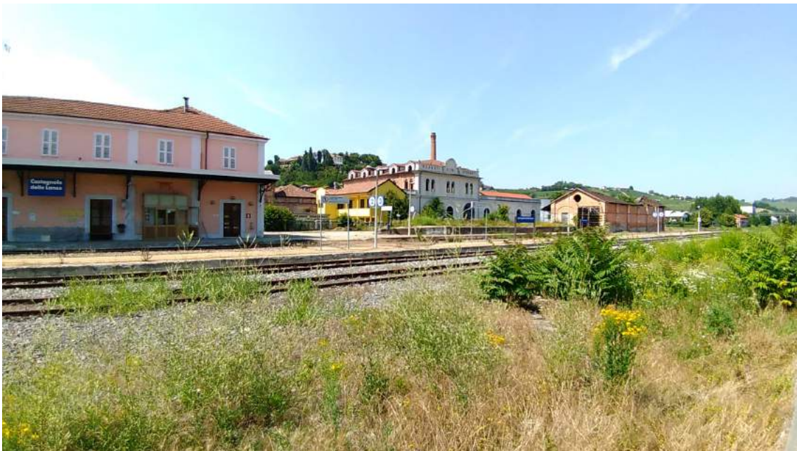
I fabbricati della stazione di Castagnole delle Lanze, la vicinanza con la cantina vinicola era strategica per lo spostamento dei prodotti enologici, foto dell'autore.
