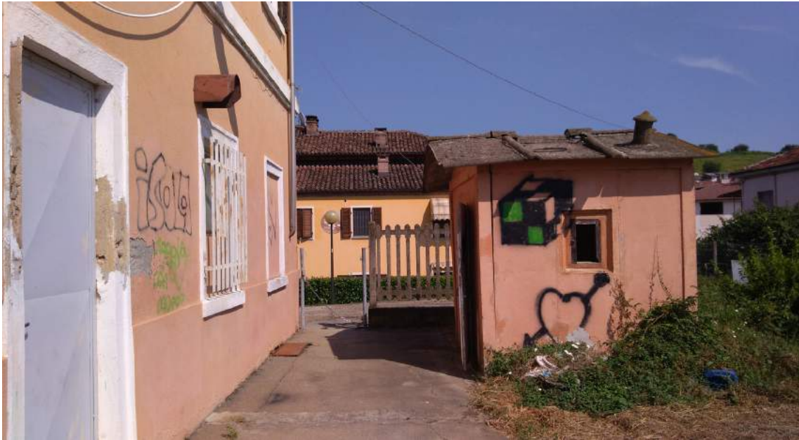
Area esterna della stazione di Isola d'Asti, nonostante l'impegno del locale gruppo di Protezione Civile nel ripulire la stazione, le aree pertinenziali risultano in stato di degrado, foto dell'autore.
