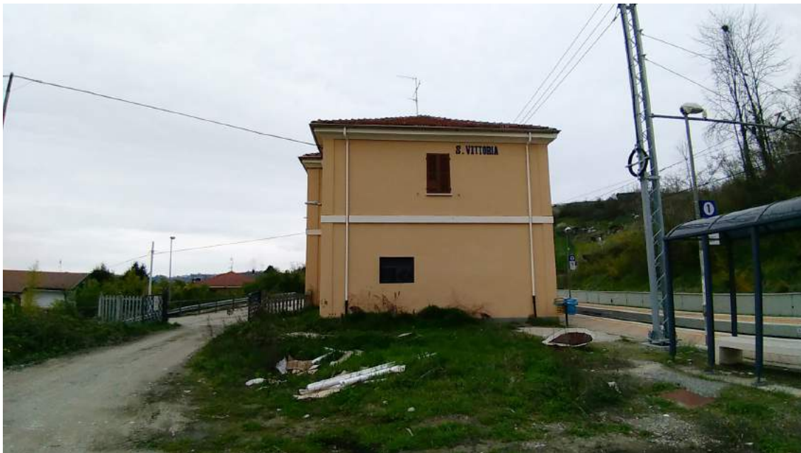
Area esterna nella stazione di Santa Vittoria d'Alba, in stato di abbandono con rifiuti abbandonati ed accesso ai binari ed alla pensilina reso difficoltoso ai soggetti portatori di disabilità motorie a causa del fondo sconnesso, foto dell'autore.
