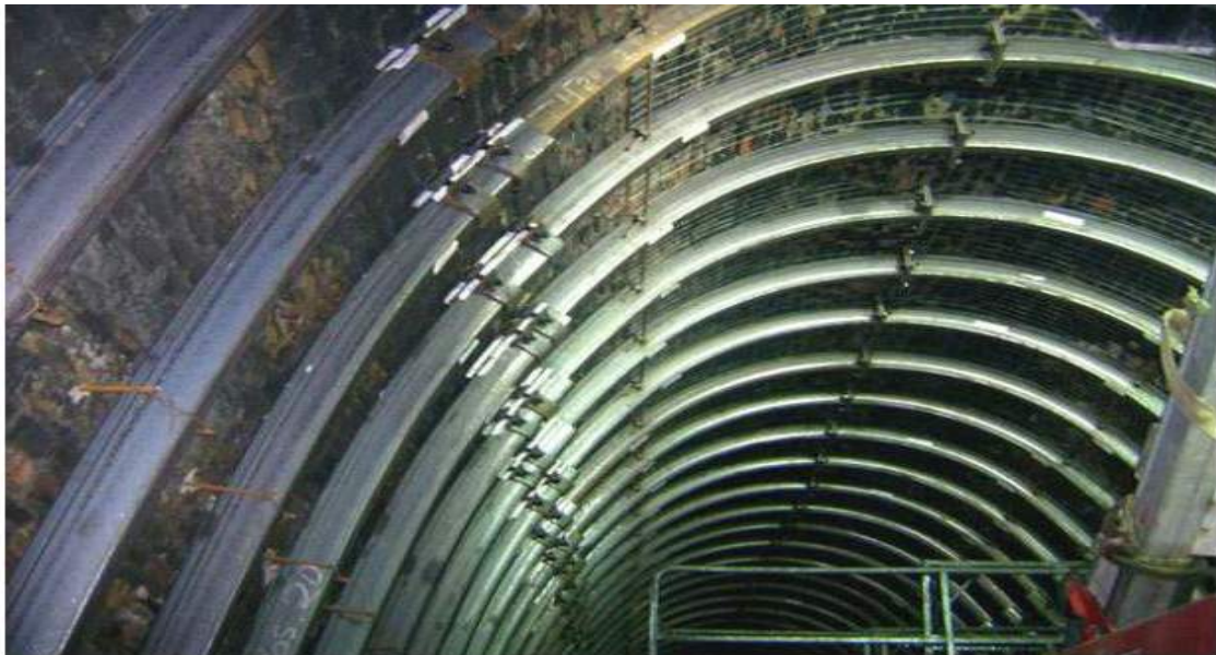
Centinatura per rinforzo della parete in muratura, immagine tratta dalla Relazione per lo Studio di fattibilità per il progetto di riqualificazione della linea ferroviaria Bra-Alba-Castagnole delle Lanze.
