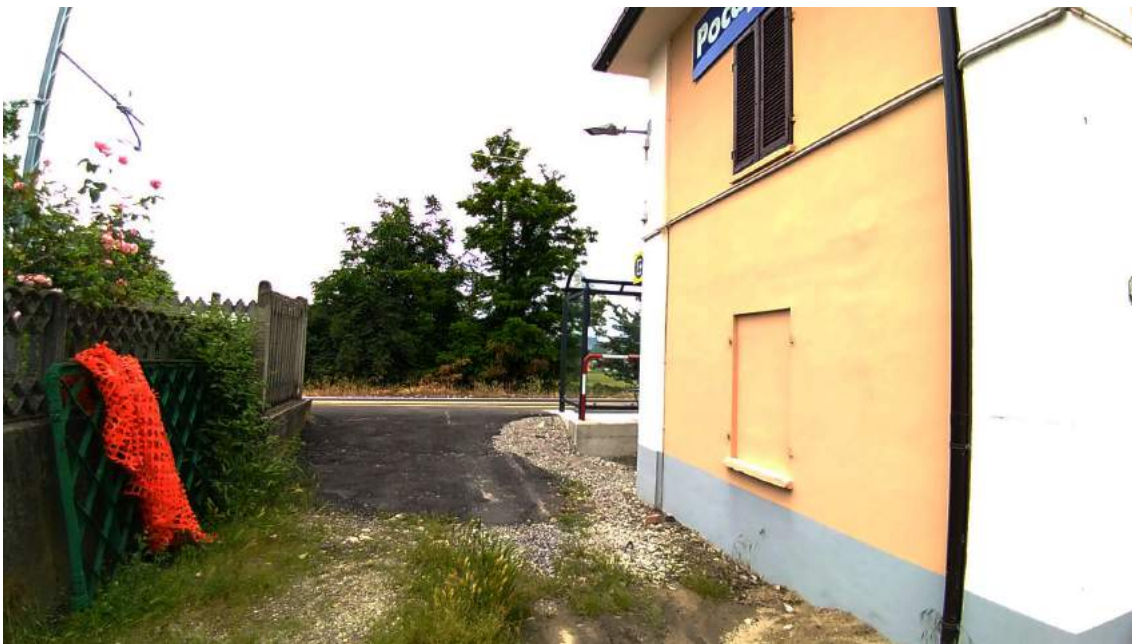
Accesso alla stazione di Pocapaglia, il fondo irregolare ed in pendenza rende difficile la fruibilità ai soggetti con difficoltà motorie, foto dell'autore.
