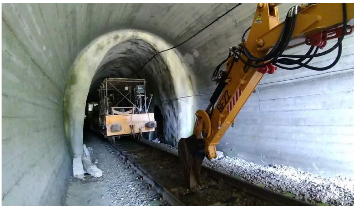
Ingresso alla galleria Martinga con mezzi ferroviari per il ripristino del sedime ferroviario e parziale eliminazione della vegetazione invasiva, foto dell'autore (17 giugno 2018).
