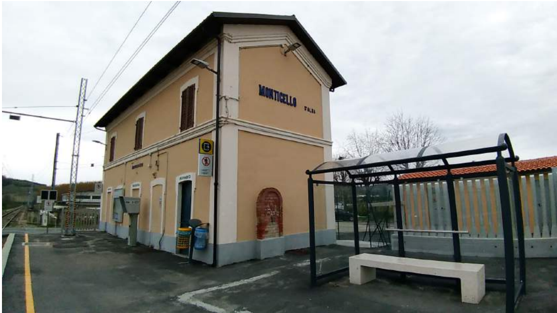
Pensilina nella stazione di Monticello d'Alba come unico spazio di riparo dalle intemperie; i locali inaccessibili del fabbricato viaggiatori non permettono di sostare in caso di flusso maggiore di viaggiatori, foto dell'autore.
