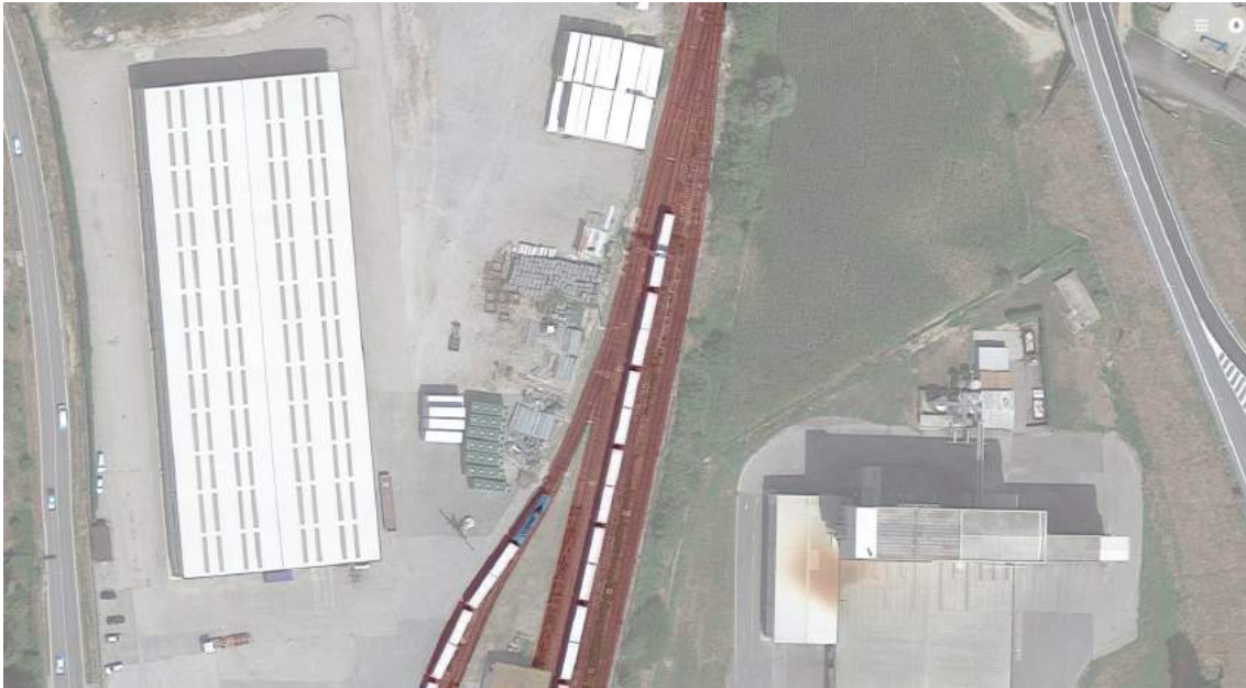
Veduta aerea della diramazione verso lo stabilimento "Sicom" presso Cherasco, immagine tratta dal sito www.google.it/maps ed elaborata dall'autore.
