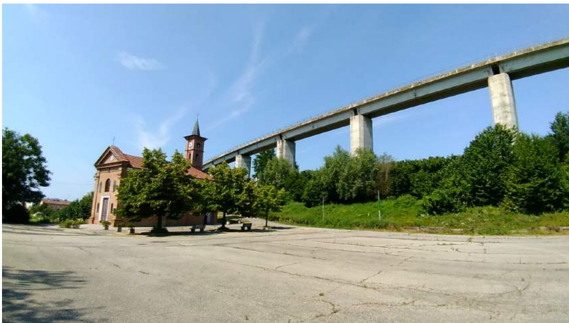
Viadotto passante per Valle Tanaro (fraz. Di Castagnole L.), foto dell'autore.
