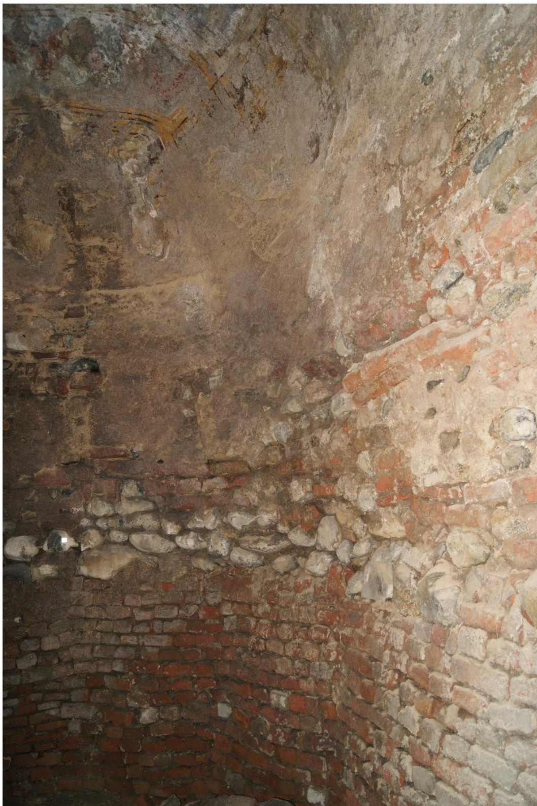
FIGURA 36 . ABSIDE DELLA NAVATA CENTRALE DELLA CAPPELLA SOTTERRANEA DELLA MADONNINA CON DIFFERENTE STRATIGRAFIA DEI MURI IN ELEVATO
