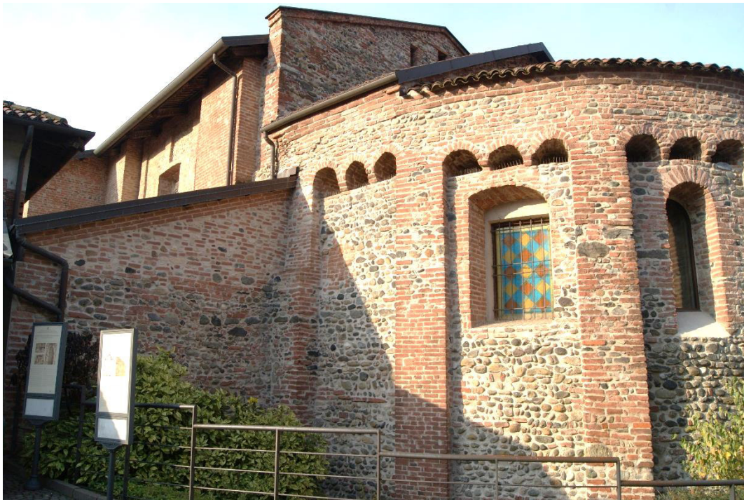
FIGURA 14 - FINESTRE RETTANGOLARI RICAVATE NELL'ABSIDE CENTRALE DELL'ABBAZIA NEL XVII SECOLO
