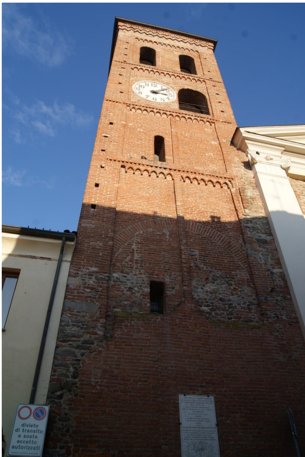
FIGURA 29 – CAAMPANILE CON TRACCE DELLA FACCIATA STORICA
