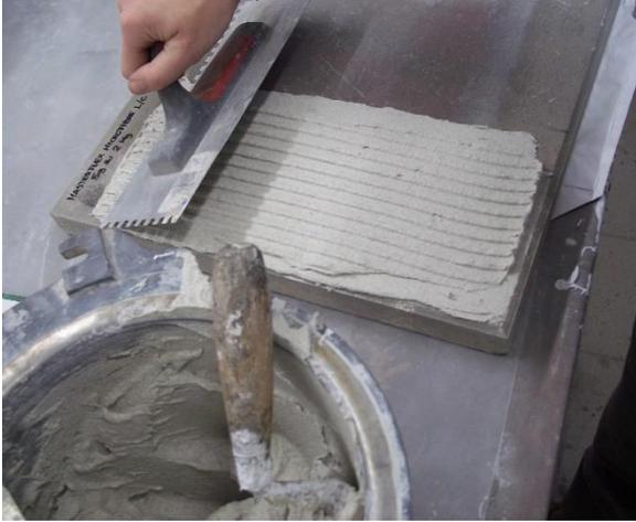
Figura 125 Applicazione secondo strato e rasatura con spatola dentata
