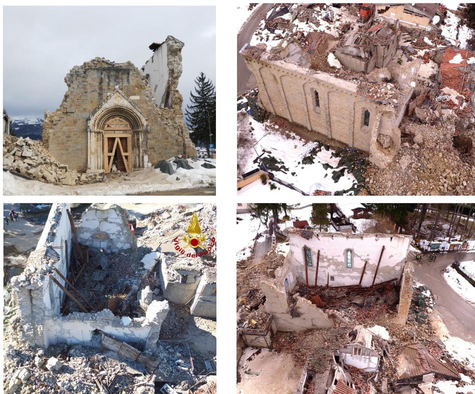
**Figura 3.10. Immagini rilievo T2 Febbraio 2017. Img.1: Proseguimento del crollo del prospetto principale (rilievo fotogrammetrico terrestre); Img.2: Prospetto Est integro, Img.3 Crollo quasi totale prospetto Sud, Img. 4 crollo quasi totale prospetto Ovest (Rilievo UAV con il drone INSPIRE 1 condotto dal gruppo RPAS dei Vigili del Fuoco).<sup>86</sup>**
