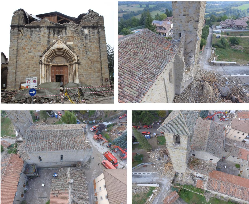
**Figura 3.8. Immagini rilievo T1 Settembre 2016. Img.1: Crollo parziale del Prospetto principale (rilievo fotogrammetrico terrestre); Img.2: Crollo totale di Porta Carbonara; Img.3-4 Prospetto Ovest, Prospetto Sud e Campanile integri (Rilievo UAV con il drone INSPIRE 1 condotto dal gruppo RPAS dei Vigili del Fuoco)**
