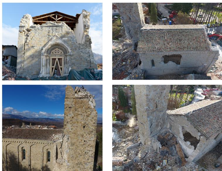
**Figura 3.9. Immagini rilievo T2 Dicembre 2016. Img.1: Proseguimento del crollo parziale del prospetto principale (rilievo fotogrammetrico terrestre); Img.2: Crollo in corrispondenza della finestra prospetto Ovest, Img.3 Crollo cella campanaria e Img. 4 crollo porzione di parete prospetto Sud e edificio adiacente retrostante (Rilievo UAV con il drone Phantom 4 condotto dal gruppo RPAS dei Vigili del Fuoco).<sup>85</sup>**
