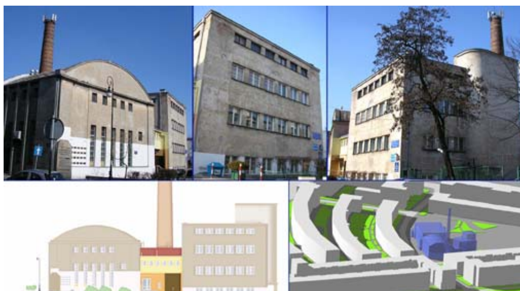
VI Kolonia: ex centrale di riscaldamento, ex lavanderia. Rilievo e rappresentazione 3D del complesso
