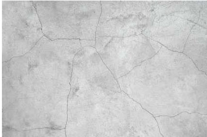
*Figura 1.4: Esempio di fessurazione del calcestruzzo dovuta al ritiro*
