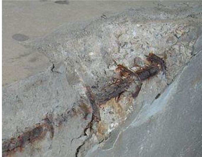
Figura 1.8: Esempio di corrosione di una barra di armatura in un elemento in calcestruzzo armato con distacco del copriferro
