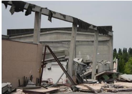
Figura 2.25. Belleri et al. (2014). Rotazione rigida del plinto alla base del pilastro
