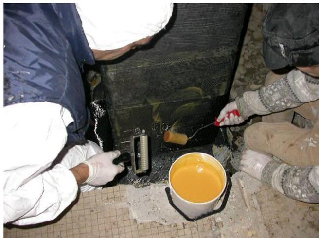
Figura 5.159. Applicazione tessuto FRP monodirezionale in direzione trasversale all'asse del pilastro per un aumento del confinamento
