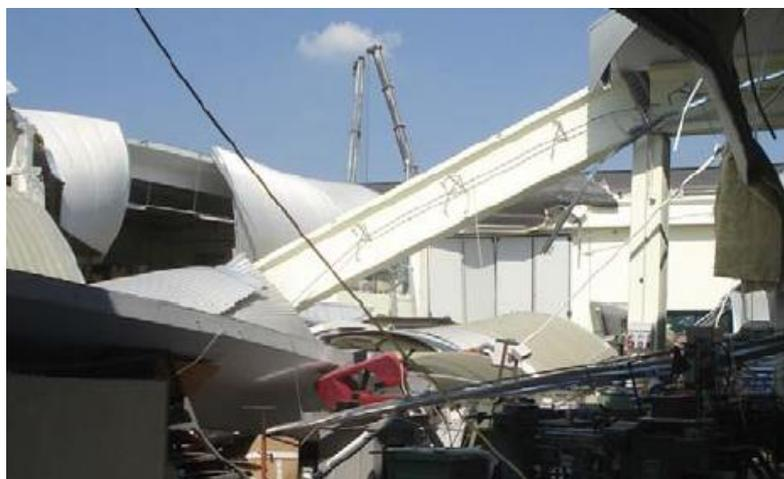
Figura 2.21. Magliulo et al. (2014) Perdita d'appoggio della trave principale (1)
