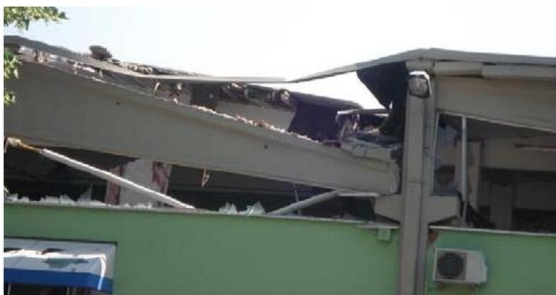
Figura 2.22. Magliulo et al. (2014). Perdita d'appoggio della trave principale (2)
