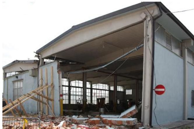
Figura 2.23. Belleri et al. (2014). Perdita di stabilità fuori piano dei tamponamenti
