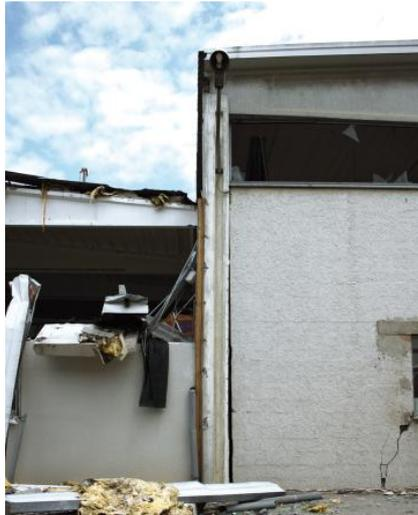
Figura 2.24. Belleri et al. (2014). Perdita di verticalità del pilastro
