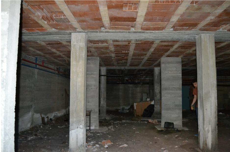
**Figura 17: Tipologia costruttiva SAP per i solai.**
