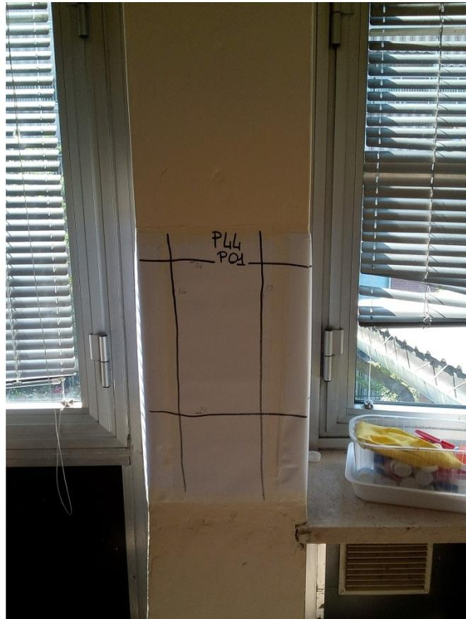
**Figura 122: Esempio di prova pacometrica su pilastro.**
