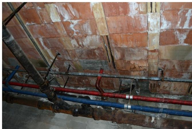
**Figura 18: Particolare di corrosione delle barre d'armatura e conseguente rottura del laterizio.**
