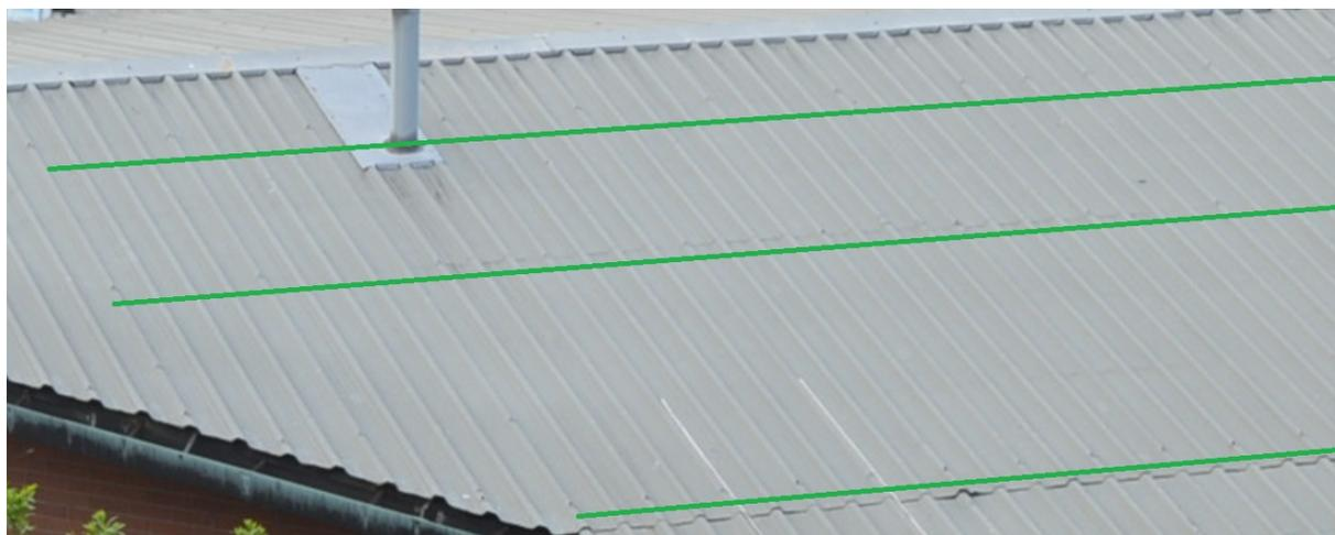
**Figura 219: Vista viti per il vincolo tetto-travi.**
