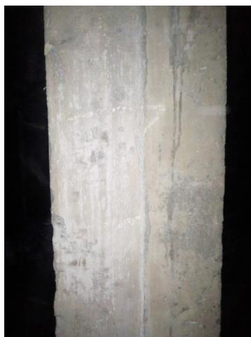
**Figura 72: Differenza pilastro trattato e non con la pietra abrasiva.**
