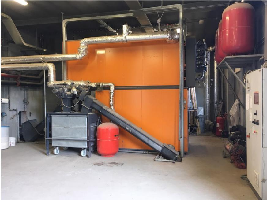
*Figura 13 Caldaia a cippato, centrale termica*
