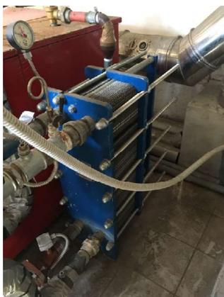
*Figura 16 Scambiatore, sottostazione*
