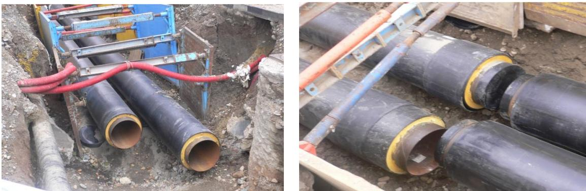
Figura 14- Esempi di posa di tubazioni per reti di teleriscaldamento [16]
