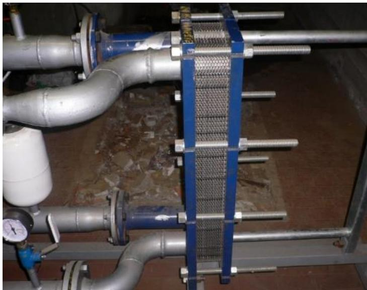
*Figura 11 - Tipico scambiatore a piastre di sottostazione [17]*
