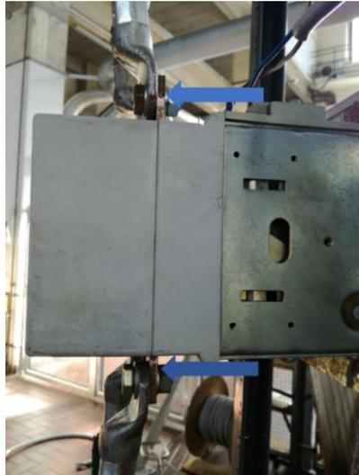
**Fig.47** Terminali sui quali è stata effettuata la misura della temperatura.
