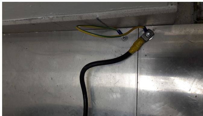
Figura A.3: Collegamento tra le lastre metalliche
