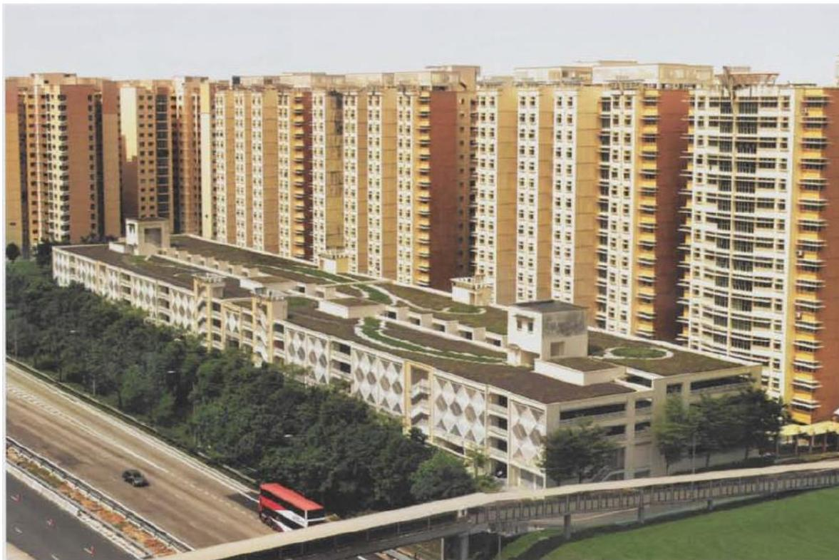
Figura 5.4-1 Parcheggio multipiano di Punggol dopo l’installazione del tetto verde [127].
