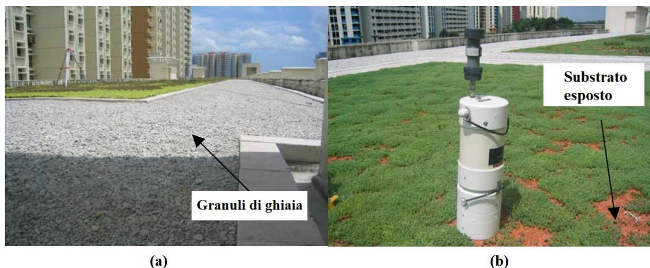
Figura 5.4-3 Possibili fonti di particolato grossolano; (a) Ghiaia presente nell'interno dei tetti verdi. (b) Substrato esposto per via della mancanza di vegetazione in alcune porzioni del tetto verde [126].
