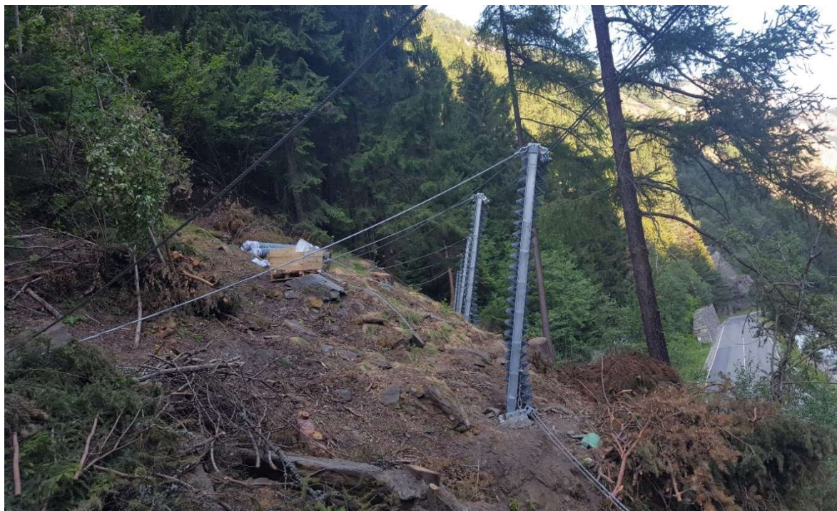
Figura 10 – Si possono notare le funi che collegano i montanti alle fondazioni a monte. In particolare, in questa foto sono evidenti le funi di controvento di monte (scattata il 20 giugno 2018 nel sito di Aymavilles).
