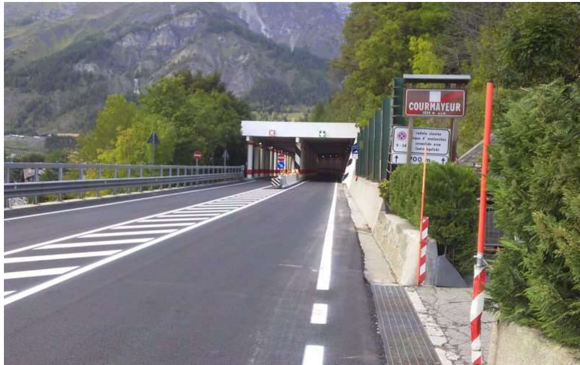
Figura 3 – Galleria paramassi sulla Strada Statale 26 a La Saxe, tra Courmayeur e Entreves (foto presa dal sito ufficiale di “Mattioda Pierino & Figli S.p.A”)
