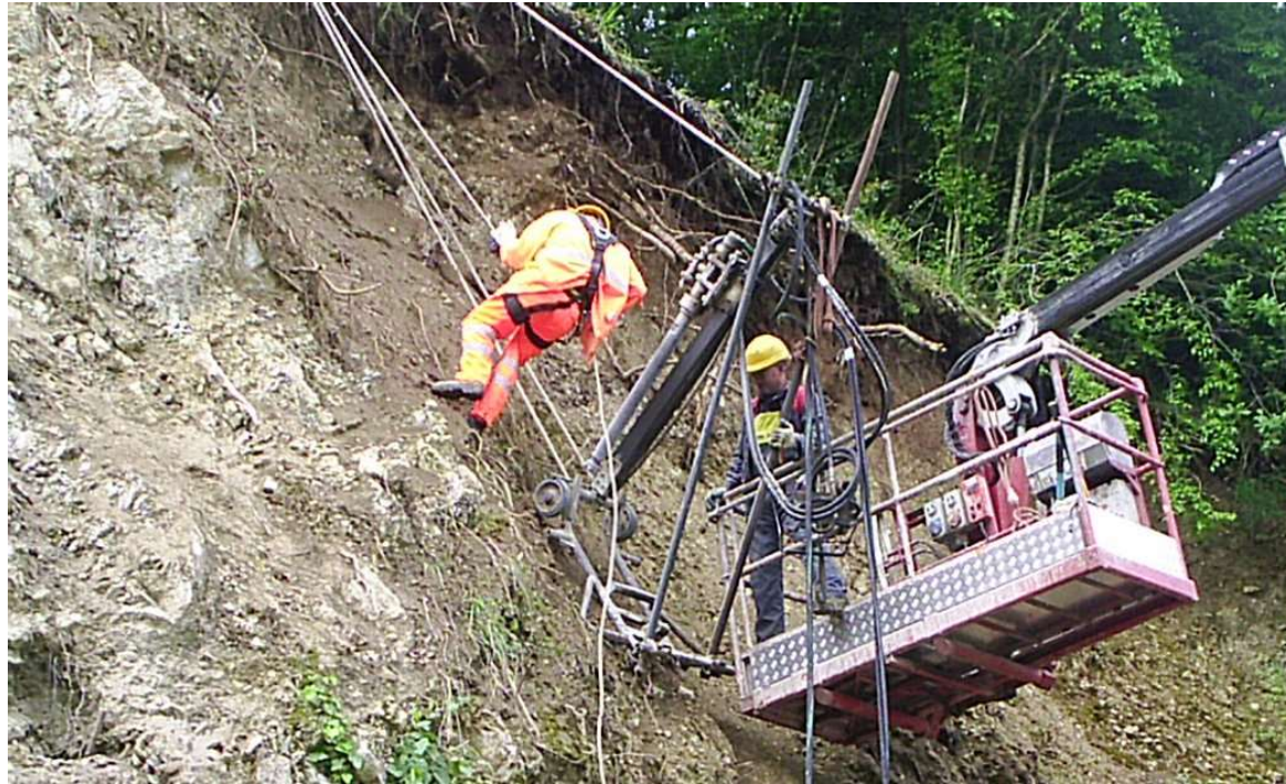
Figura 19 – Foto di una perforazione tramite slitta.
