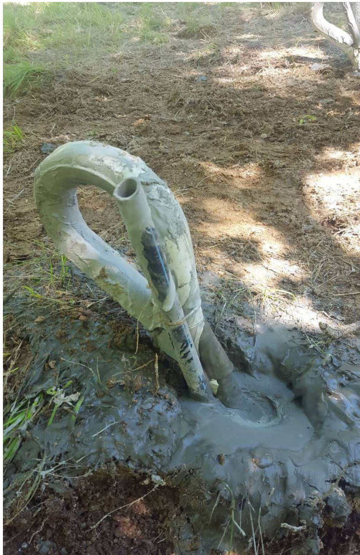
Figura 20 – Dettaglio del tubo di iniezione; è ben evidente la boiacca cementizia iniettata fino al piano campagna (foto scattata in data 14 giugno nel sito di Valtournenche).
