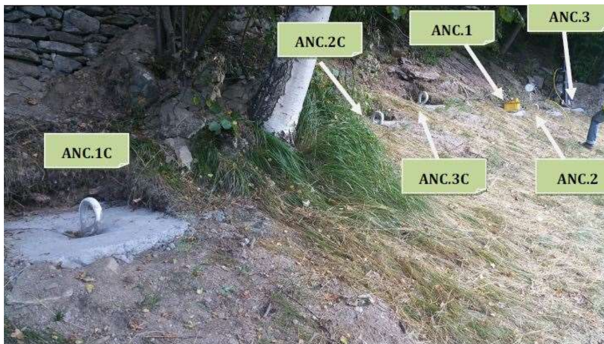
Figura 60 – Collocazione degli ancoraggi di prova del sito di Valtournenche, i cui risultati sono riassunti nelle due tabelle seguenti (15 e 16).
