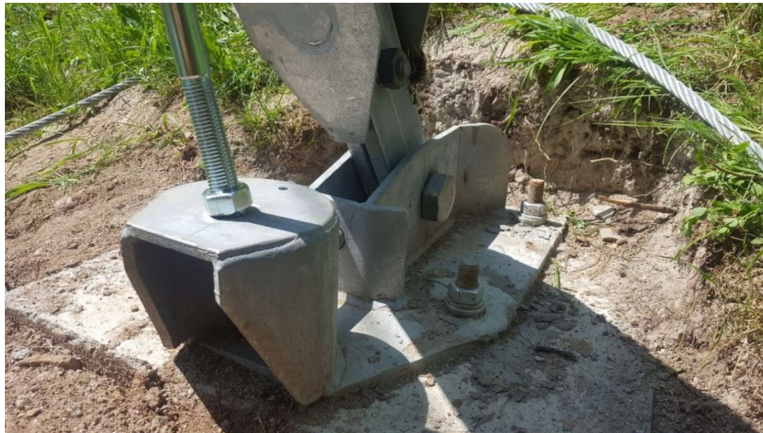
Figura 11 – Particolare del plinto di fondazione con piastra (foto scattata il 10 luglio 2018 sul sito della barriera di Valtournenche).
