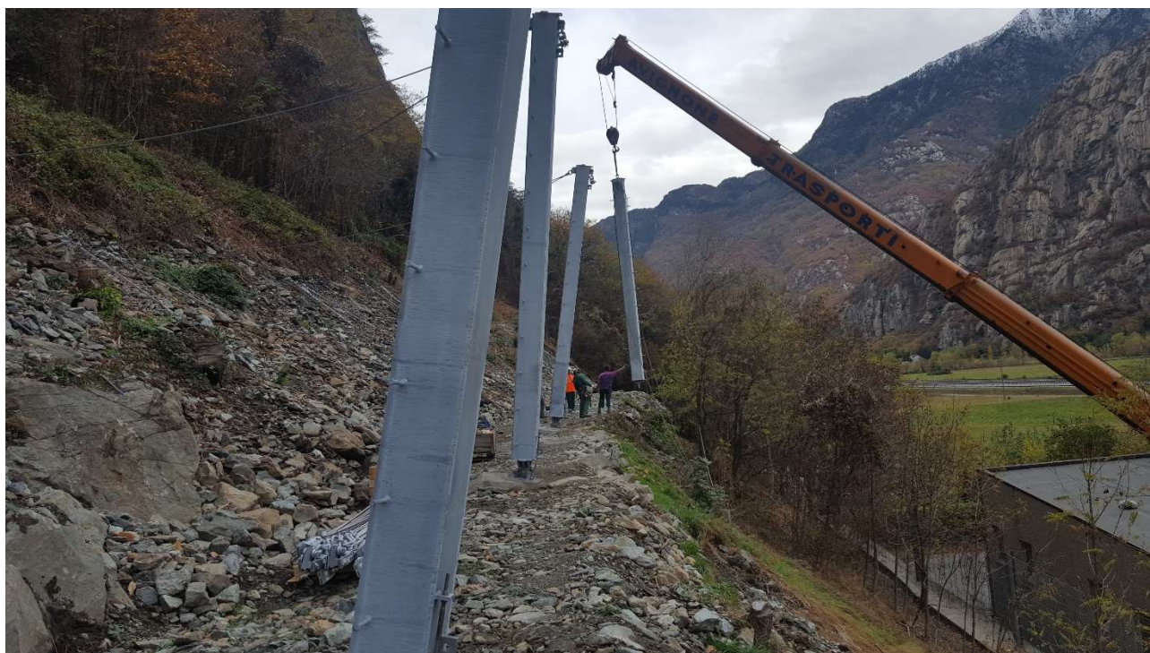
Figura 36 – Foto dell'autogrù in movimento. Si può osservare, in secondo piano, la posa di un montante, mentre in primo piano si vedono alcuni piloni già installati in fase preliminare, con le relative funi, ancora visibilmente lasche.
