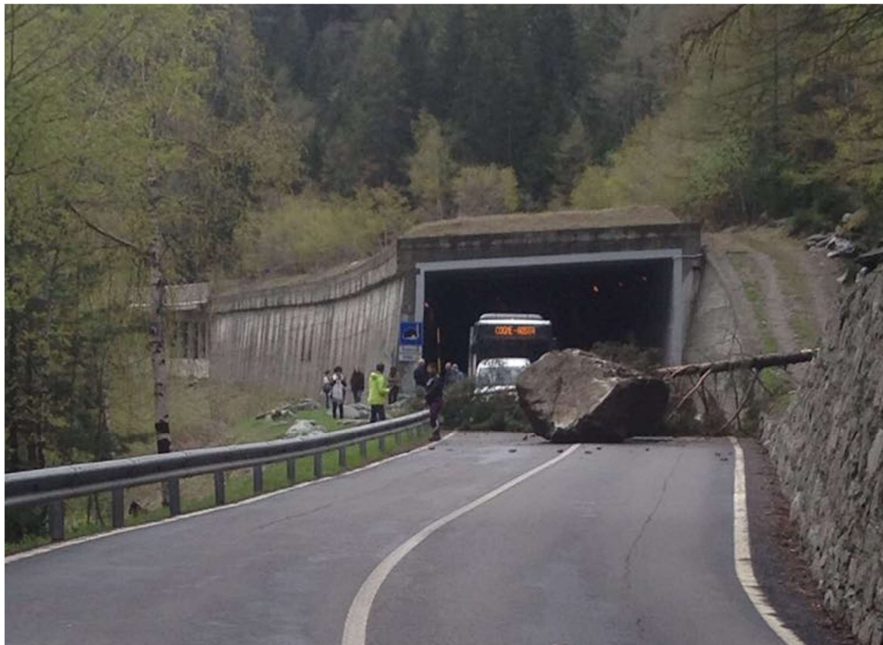
Figura 1 – Fenomeno di caduta massi sulla strada regionale di Cogne, Valle d'Aosta. L'evento risale al 4 maggio 2018 (foto ANSA).
