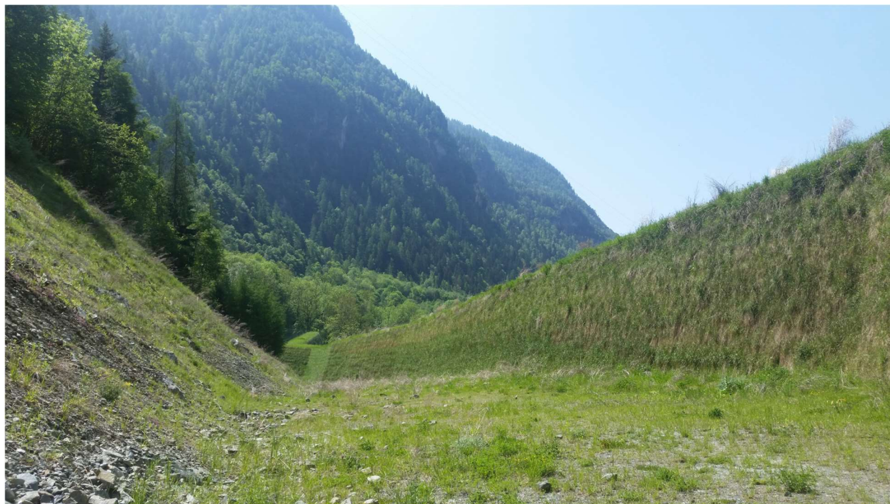
Figura 2 - Rilevato in terra rinforzata a protezione del “Villaggio turistico camping Cervino” nel comune di Antey-Saint-André. Si nota il completo inerbimento della struttura che consente un minor impatto ambientale (foto scattata il 9 giugno 2018).
