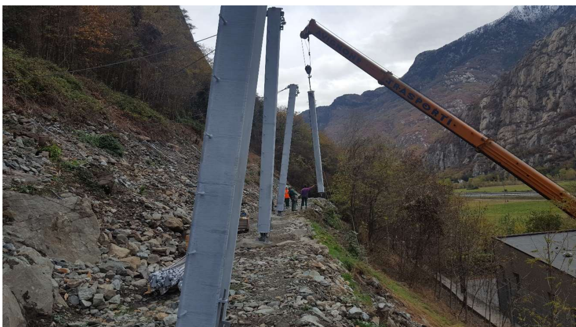
Figura 8 – Montanti della barriera installata nel comune di Hône. In questa immagine, essi sono stati appena posizionati sui plinti di fondazione, e dovranno poi essere inclinati della corretta inclinazione. La foto risale a metà del mese di novembre 2017.
