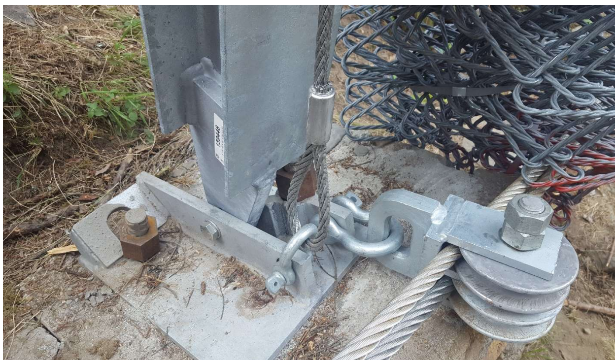
Figura 55 – Fondazione della barriera GBE-2000A con la tecnica dei due micropali, uno verticale ed uno inclinato (foto scattata il 10 luglio 2018).
