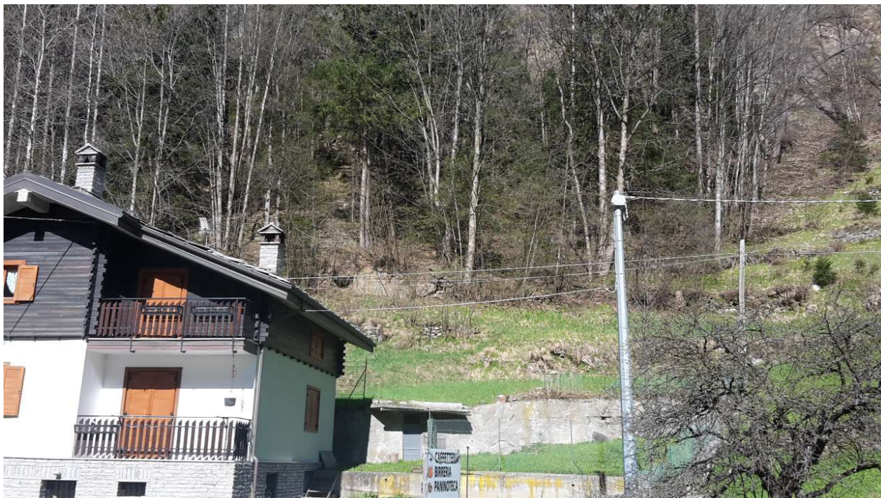
Figura 58 – Foto presa dalla relazione fotografica realizzata dall’ente della Regione Valle d’Aosta. In corrispondenza del palo, indicativamente, vi sarà il termine del Lotto I e il conseguente inizio di sviluppo del Lotto II (la foto è stata scattata dalla strada regionale n.46).
