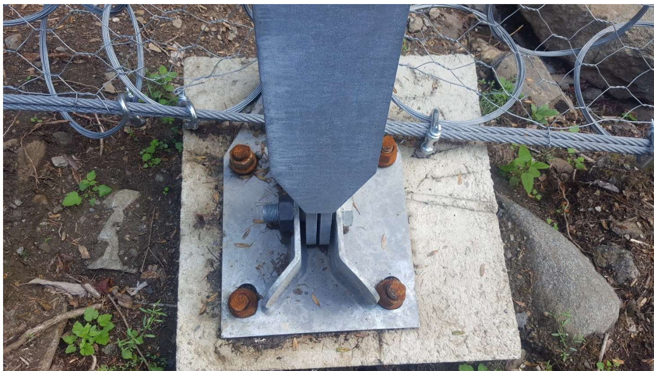
Figura 56 – Fondazione della barriera paramassi 2000 kJ della Maccaferri con la tecnica dei “4 fittoni”, disposti verticalmente sui vertici della piastra di acciaio, installata sul plinto in cemento (foto scattata in data 22 agosto 2018).
