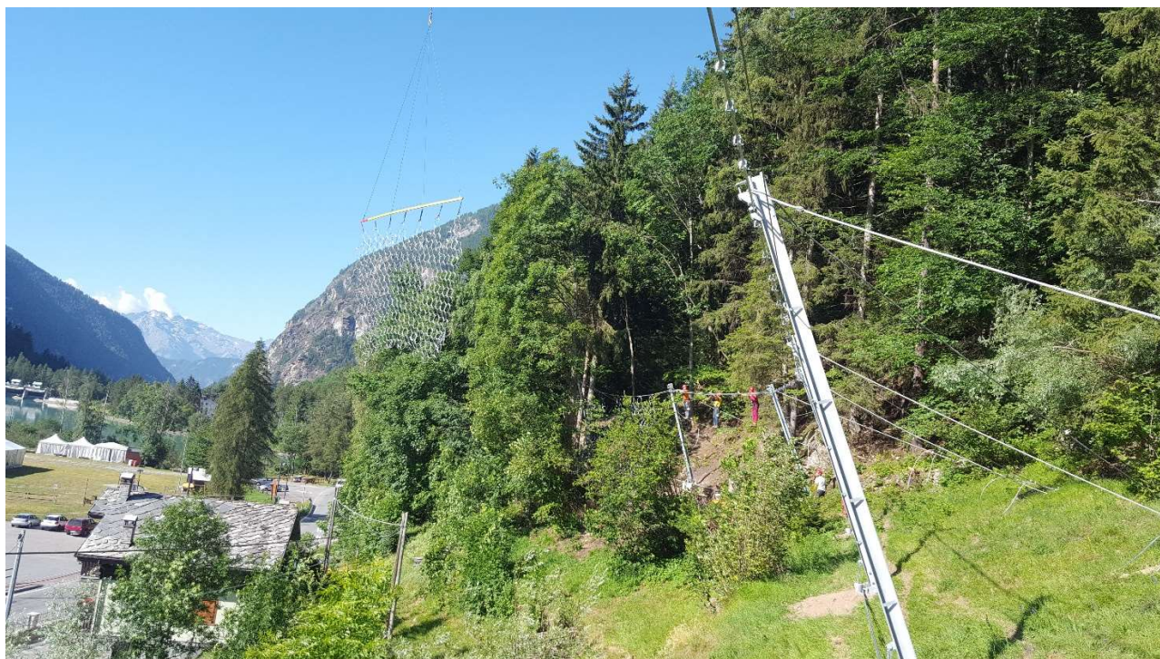
Figura 62 – Fase di trasporto del materiale (foto scattata in data 13 luglio 2017). Si vede la campata aperta di anelli in arrivo, portata dall'elicottero, verso la struttura. In lontananza si scorgono gli operai appesi alle funi di collegamento tra i montanti.
