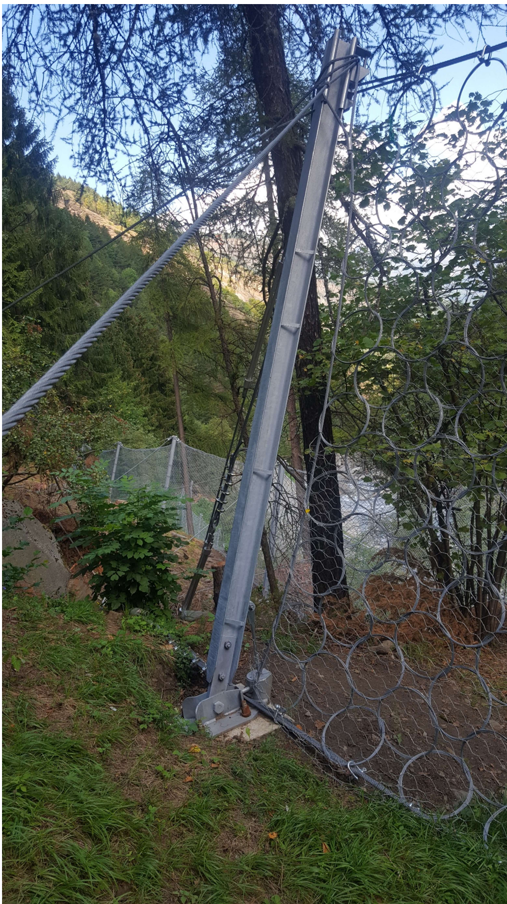
Figura 52 – Foto scattata a lavori ultimati (in data 22 agosto 2018). In primo piano si vede il montante laterale del Lotto III (il più a monte), al di sotto si notano le varie campate della barriera paramassi del Lotto II. Si scorge, infine, più in basso, attraverso la barriera di mezzo, la struttura del Lotto I, che si trova in prossimità del ciglio stradale.
