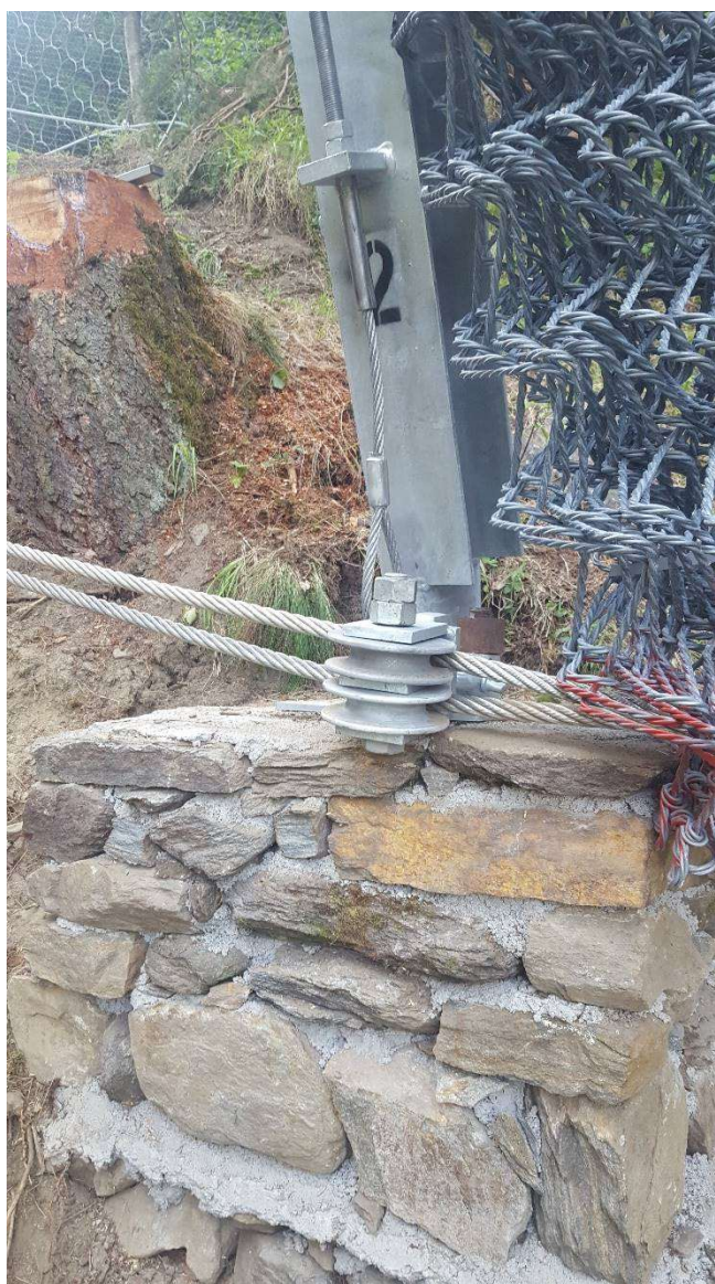
Figura 54 – Particolare della base del montante, con la costruzione di un muretto di sostegno (foto risalente al 10 luglio 2018).
