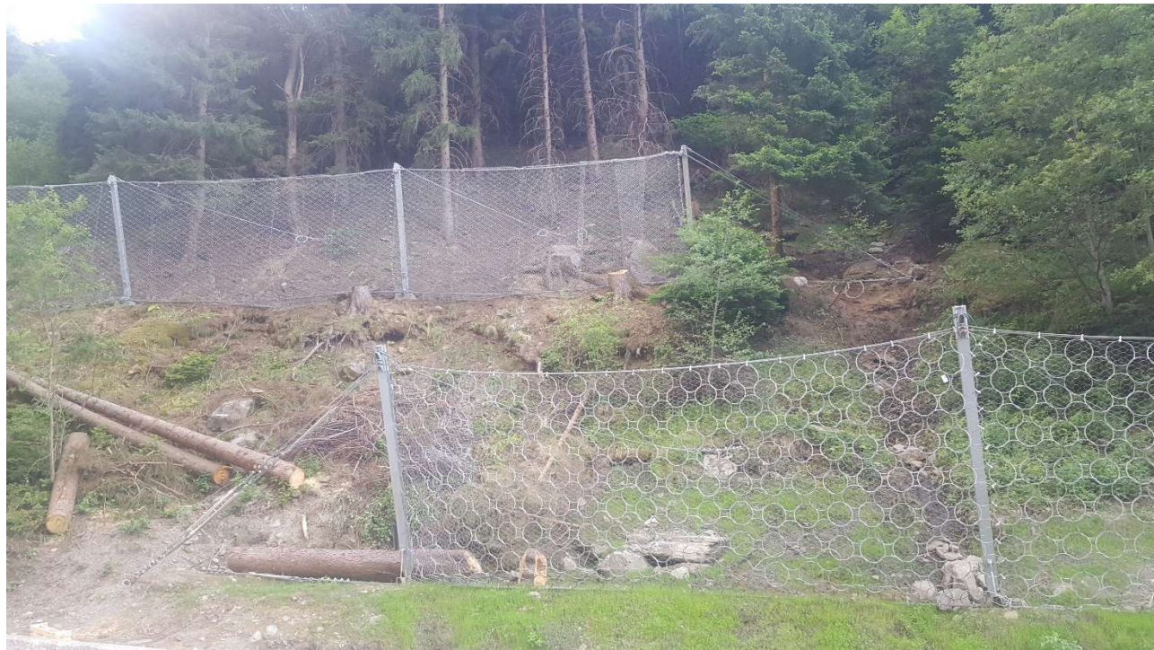
Figura 12 – Esempio di due barriere paramassi collocate su più file. Si nota chiaramente come la struttura sovrastante si sovrapponga, a livello di traiettoria, di una campata alla barriera sottostante (foto scattata l'11 luglio 2018 sul sito del cantiere nel comune di Aymavilles).
