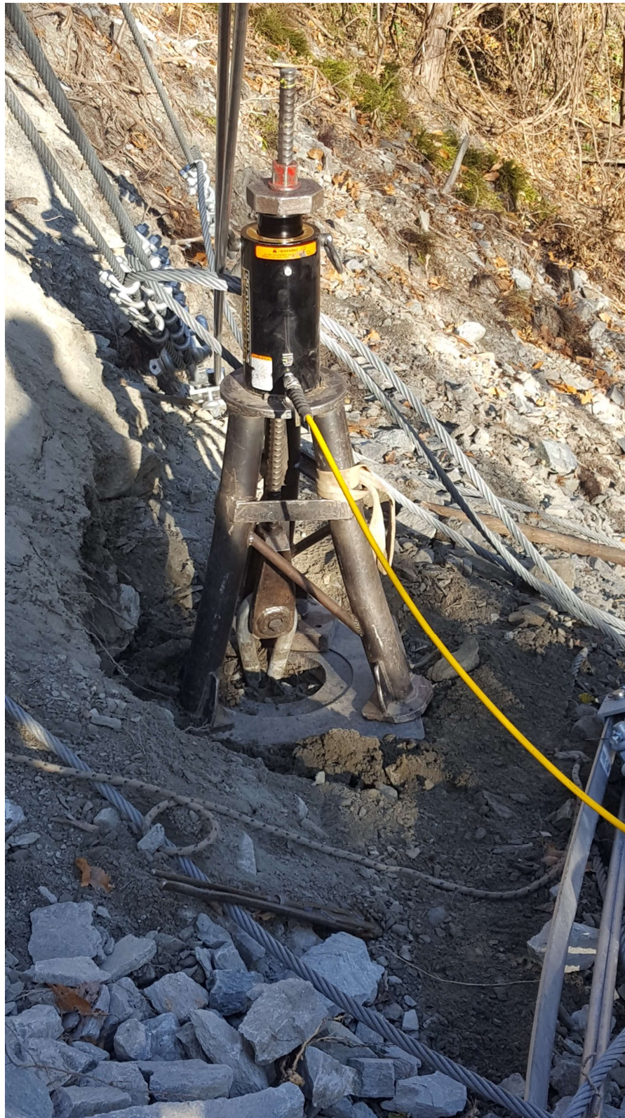
Figura 22 – Foto di un martinetto idraulico in azione, scattata il 17 novembre 2017 nel sito della barriera 8000 kJ situata nel comune di Hône.
