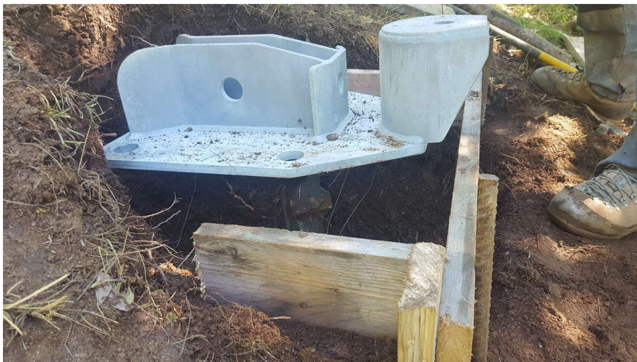
Figura 61 – Fase di preparazione per il getto che andrà a formare il plinto (foto scattata il 14 giugno 2018). Si nota l’ancoraggio, attorno al quale è stato scavato il terreno che “ospiterà” il plinto di sostegno.
