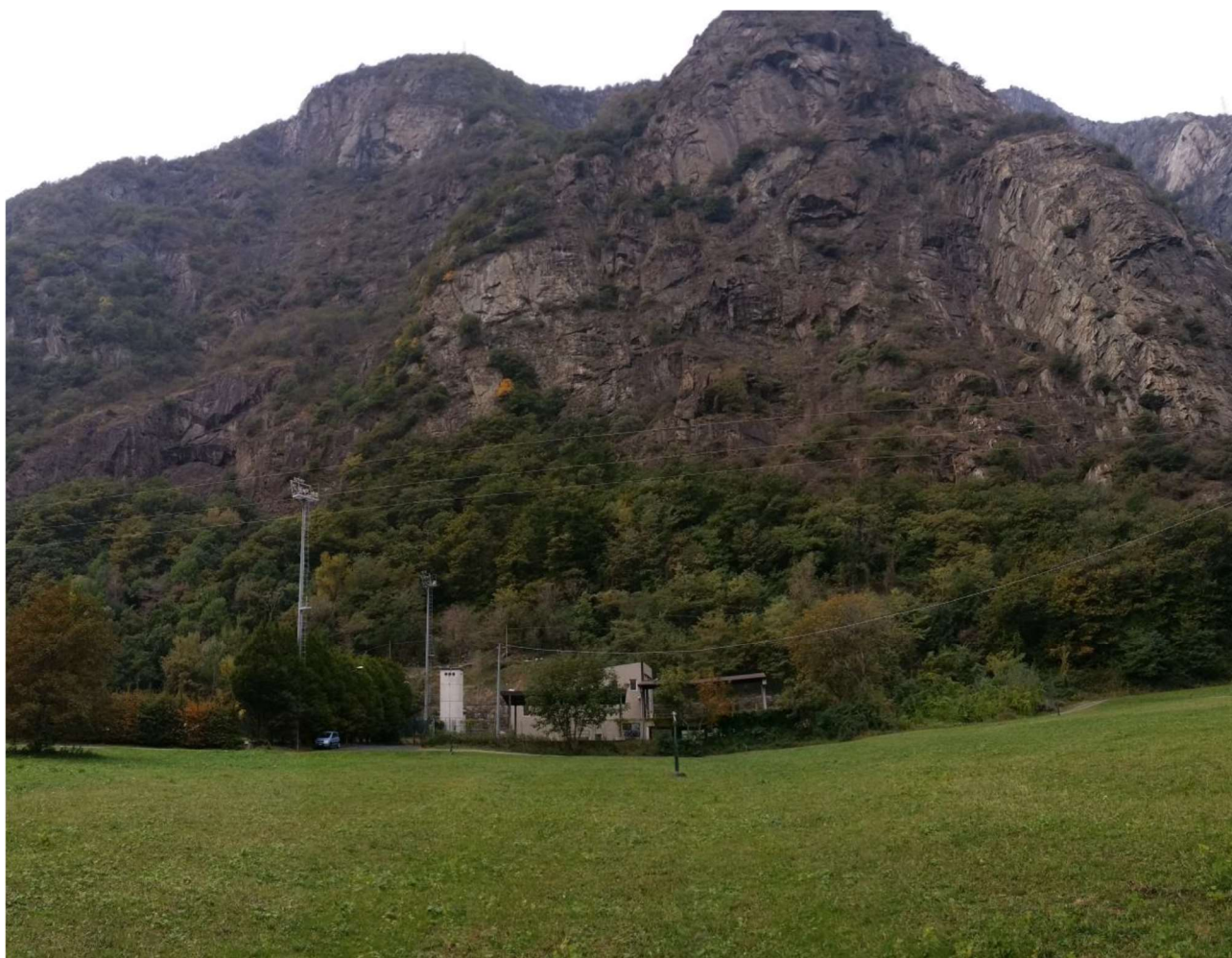
Figura 29 – Foto panoramica della parete rocciosa e del centro conferimento rifiuti sottostante (foto scattata prima dell'inizio dei lavori di preparazione dell'area d'interesse per la barriera).
