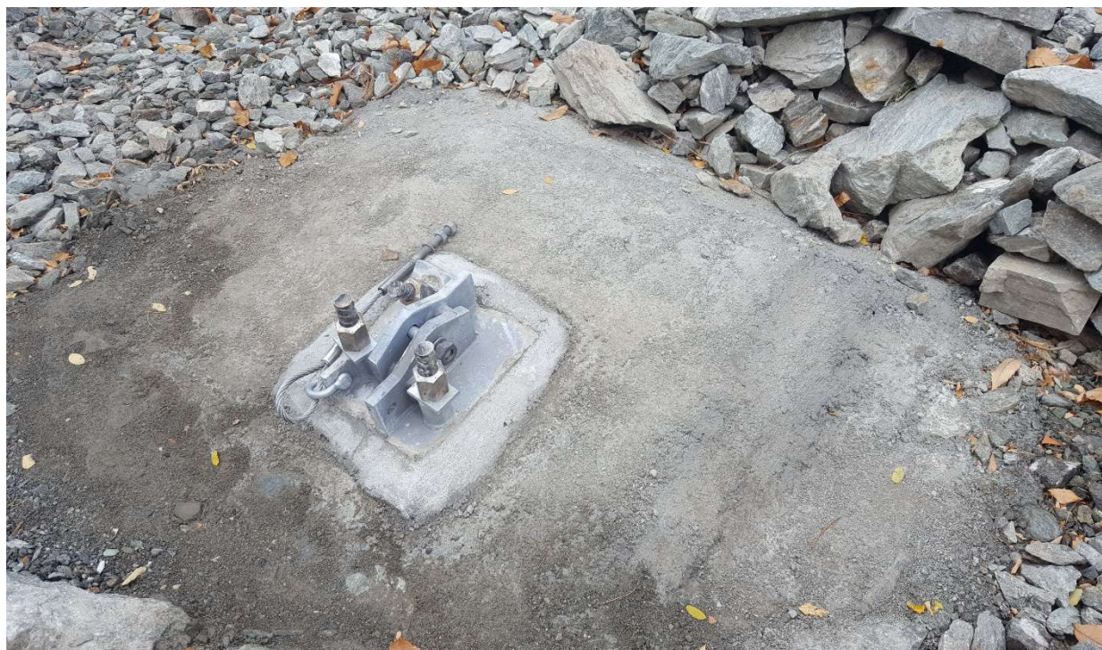
Figura 35 – Foto della piastra, cementata sopra il plinto in calcestruzzo. Sulla piastra stessa verranno installati i montanti della barriera (foto scattata in data 6 novembre 2017, nel sito di Hône).
