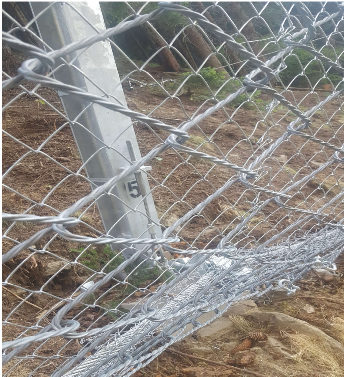
Figura 7 – Barriera Geobrugg installata nel comune di Aymavilles (10 luglio 2018). Si può notare una magliatura più larga, a forma di losanga, realizzata dall'intrecciamento di più fili, ed una maglia più fine, anch'essa di forma rombica, per trattenere eventuali blocchi di dimensioni inferiori.
