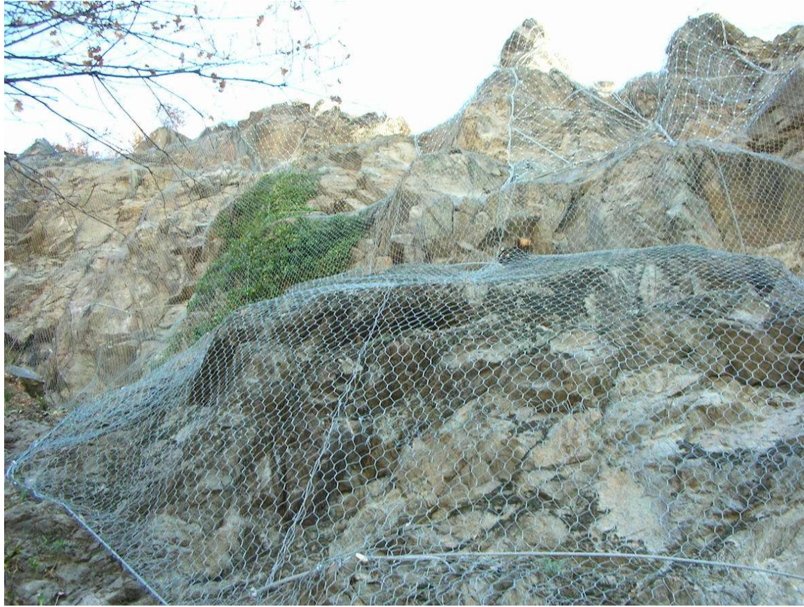
Figura 4 – Esempio di rete in aderenza su una parete rocciosa (presa dal sito ufficiale di “Consolrocce srl”).
