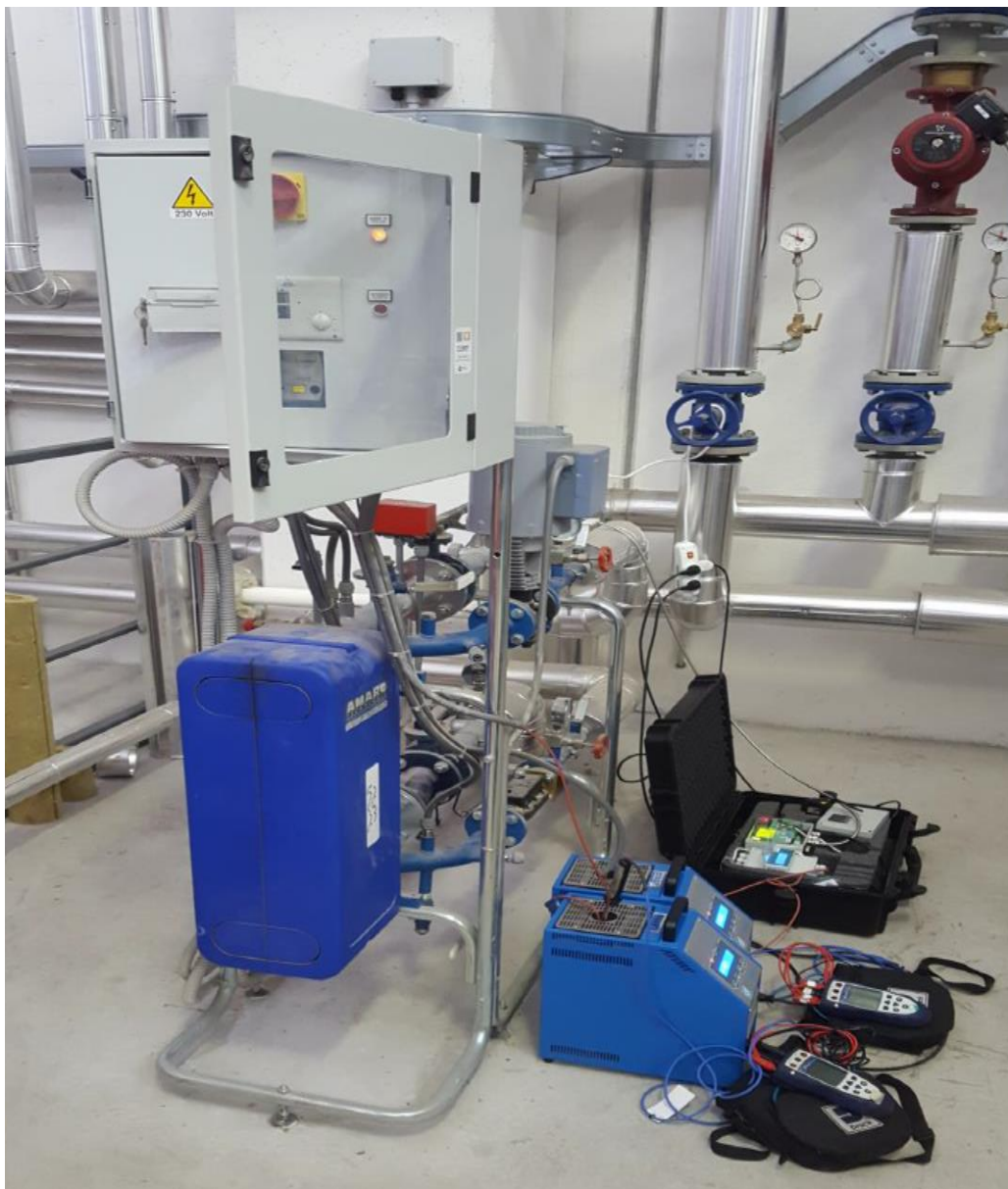
Figura 82: Installazione completa del misuratore di energia termica CSQ [29]
