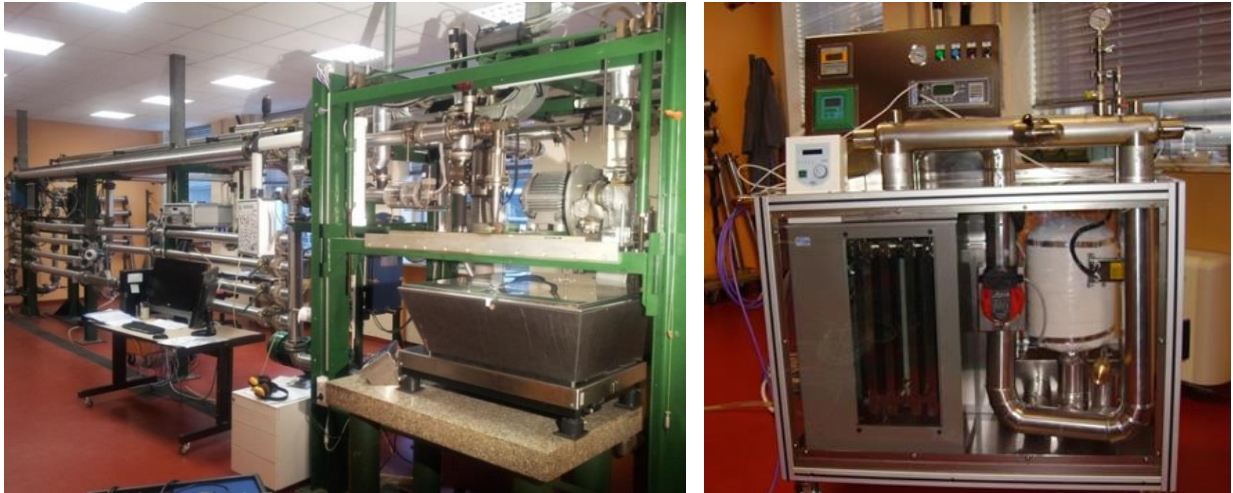
Figura 85: Campione nazionale dell'INRiM per la misura di portata d'acqua ed energia termica: a sinistra, il campione di portata; a destra, il circuito ausiliario ad elevata temperatura
