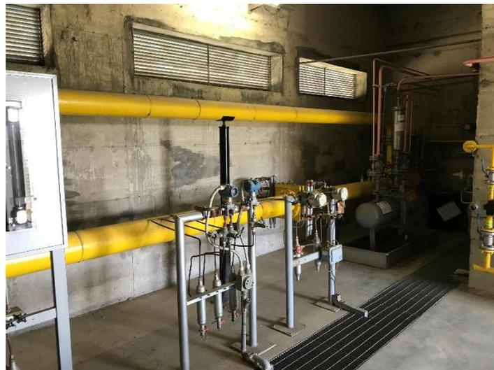
*Figura 13 Sezione di misura*
