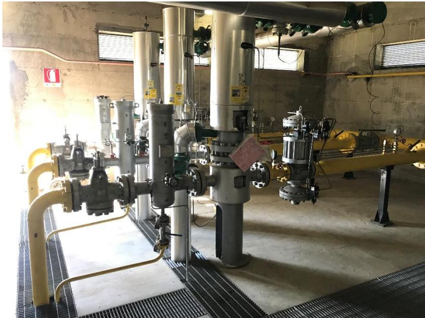
*Figura 11 Linee di riduzione del gas naturale*
