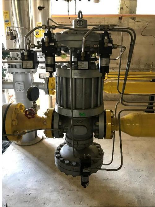
*Figura 12 Regolatore per la laminazione del gas naturale*
