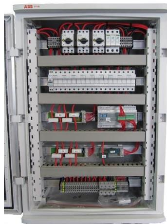
*Figura 10.6.4 Esempio di quadro DC parallelo stringhe*
