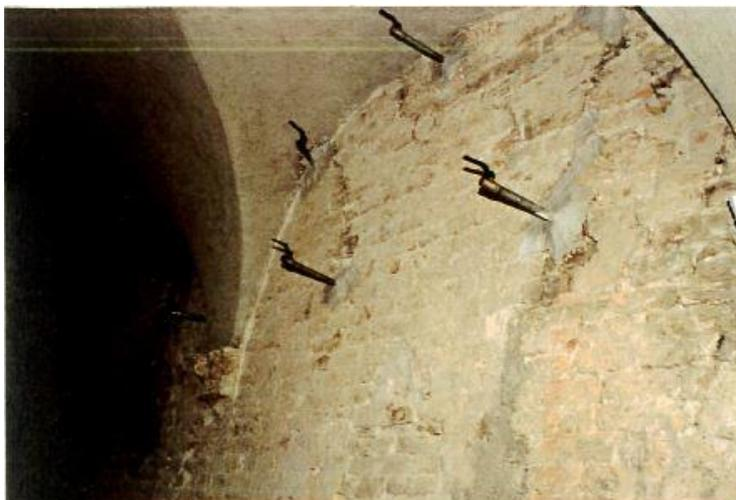
*Fig. 4.4 Inserimento tondini in acciaio nelle strutture orizzontali del piano seminterrato*
