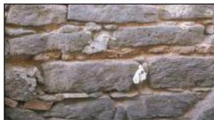
Fig. 2.17 Abaco delle murature sbazzate (Manuale AeDES)
