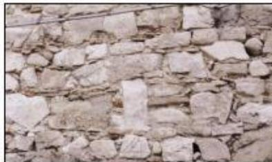
*Fig. 2.15* Abaco delle murature irregolari (Manuale AeDES)
