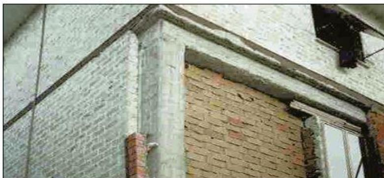
Fig. 2.27 Esempio di tamponatura arretrata rispetto alla maglia strutturale
