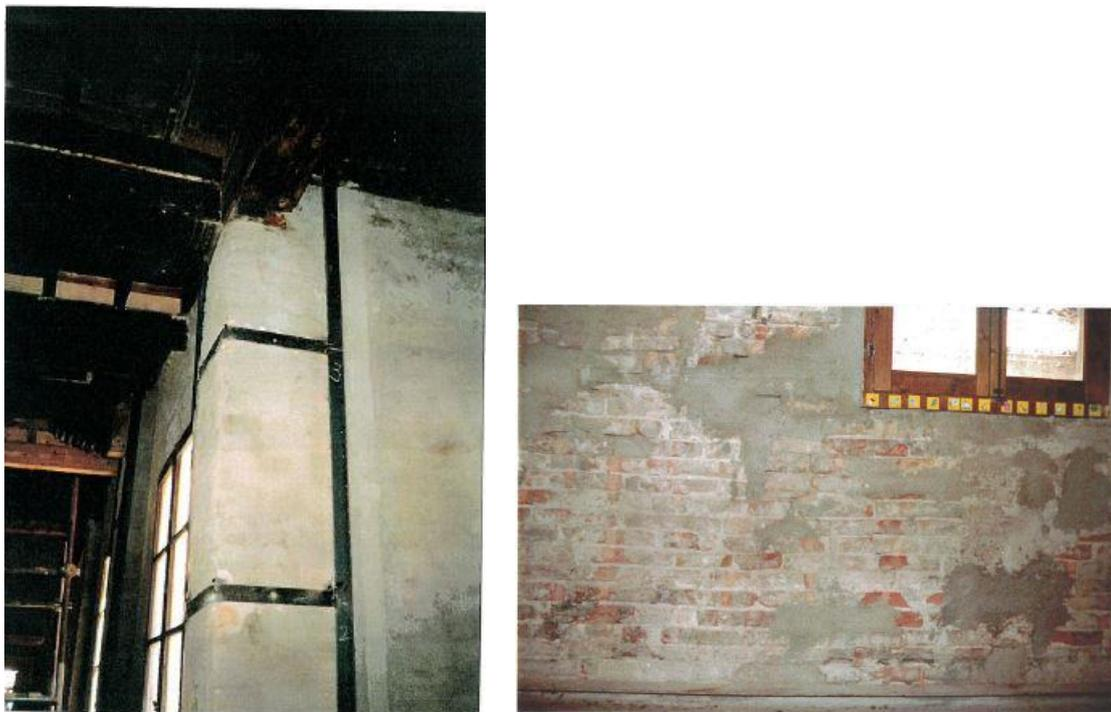
*Fig. 4.9 Rinforzo strutturale nelle murature e iniezioni di malta di latte, di cemento e acqua additivata con resine epossidiche*
