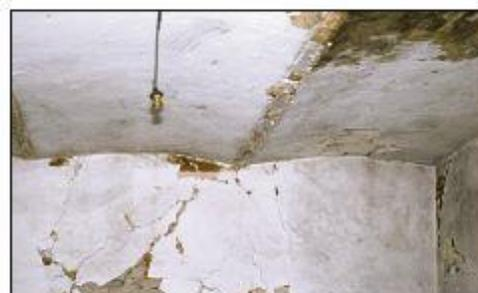
Solaio con travi di ferro a voltine.
