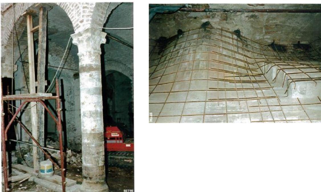
*Fig. 4.8 Consolidamento delle volte*
