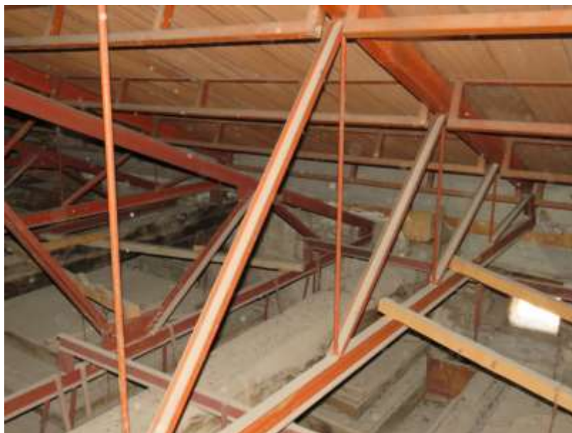
Figura 19 Capriata in acciaio che sorregge il tetto della struttura (rif. fotografie acquisite durante un sopralluogo da parte del team del Politecnico di Torino)
