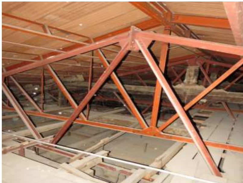
Figura 18 Capriata che regge il cassettonato (rif. fotografie acquisite durante un sopralluogo da parte del team del Politecnico di Torino)
