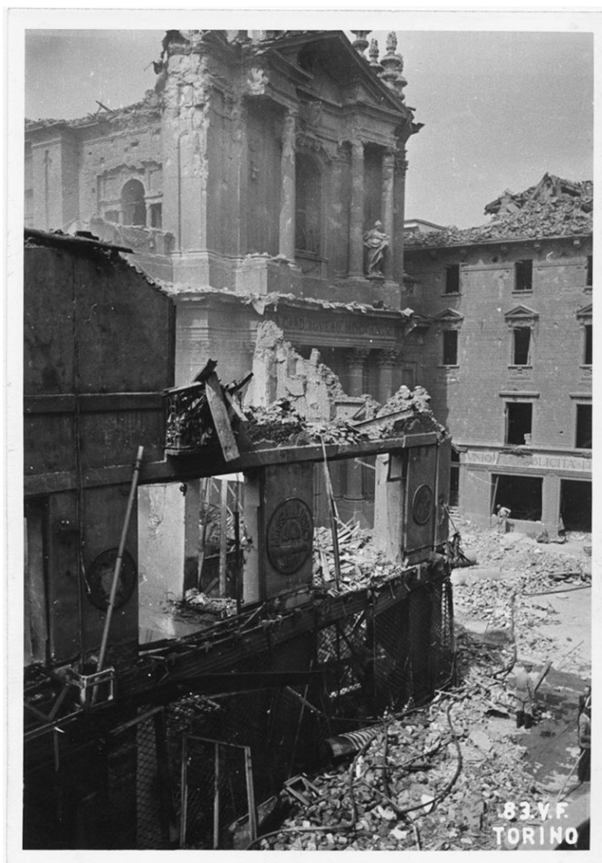
Fig. 43-44 Foto ritraenti lo stabile distrutto nel corso dei bombardamenti del 13 luglio 1943 posto all'an- golo tra via Santa Teresa e via XX Settembre. (ASCT, UPA 3614_9D06-59) (ASCT, UPA 3613_9D06-58)
