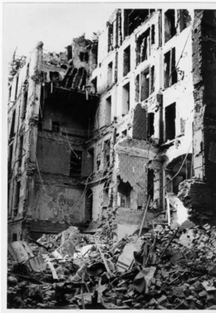
Fig. 30 Via San Quintino. Effetti prodotti dai bombardamenti dell'incursione aerea del 4-5 febbraio 1943: edifici di civile abitazione. (ASCT, UPA 3322_9D04-57)
