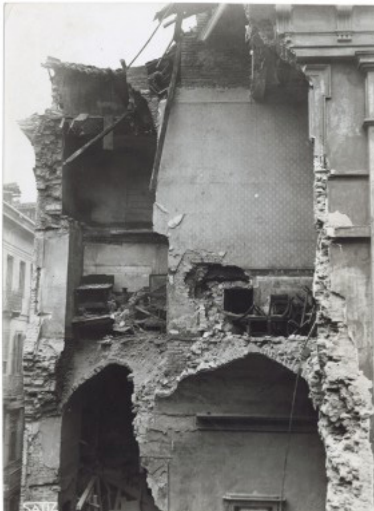
Fig. 28 Via Santa Teresa n. 20 angolo Via San Tommaso. Effetti prodotti dai bombar- damenti dell'incursione aerea dell'8 dicembre 1942. (ASCT, UPA 3054D_9D03-15)
