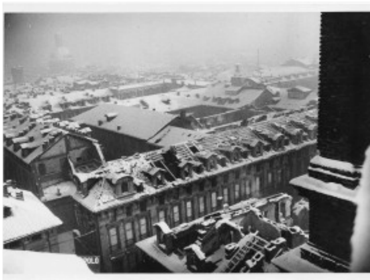
Fig. 14 Piazza Palazzo di Città. Palazzo del Municipio. Effetti prodotti dai bombar- damenti dell'incursione aerea dell'8 dicembre 1942. (ASCT, UPA 2631_9C03-51)
