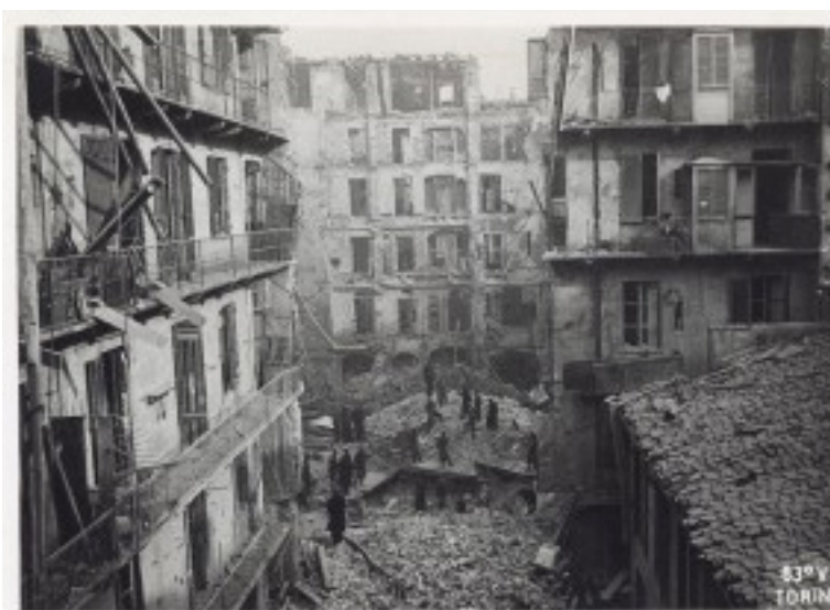
Fig. 35 Via San Quintino. La via ricoperta dalle macerie degli edifici distrutti. (ASCT, UPA 3324_9D05-01)
