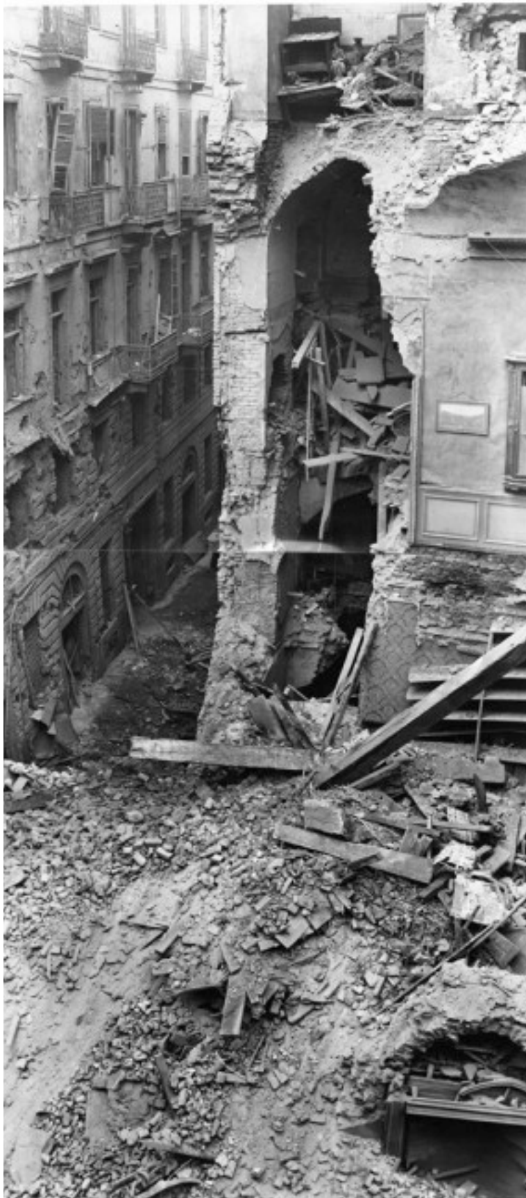
Fig. 27 Via Santa Teresa n. 20 angolo Via San Tommaso. Effetti prodotti dai bombardamenti dell'incursione aerea del 9 dicembre 1942. (ASCT, UPA 3051_9F02_58)
