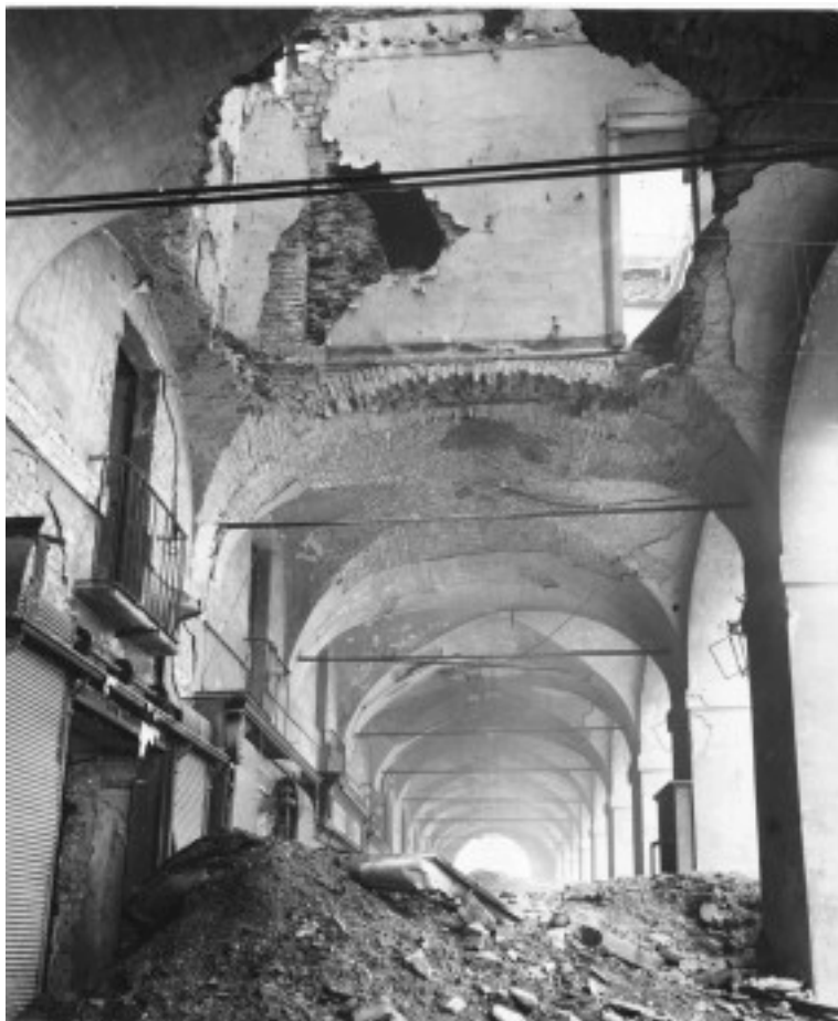
Fig. 22 Via Po. Volta del porticato distrutta dai bombardamenti dell'incursione aerea del 9 dicembre 1942. (ASCT, UPA 3065_9D03-22)
