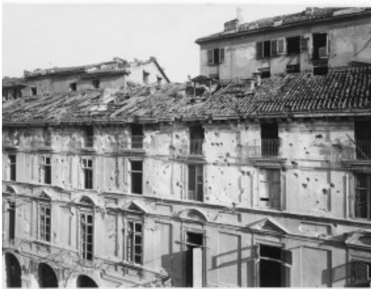
Fig. 24 Via Po. I segni dei mitragliamenti sulle facciate settecentesche di via Po. (ASCT, UPA 3067_9D03-24)
