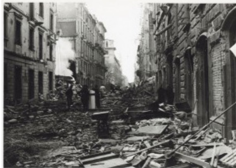
Fig. 33 Via San Quintino. La distruzione lungo la via a seguito dei bombarda- menti. (ASCT, UPA 3327D_9D05-09)
