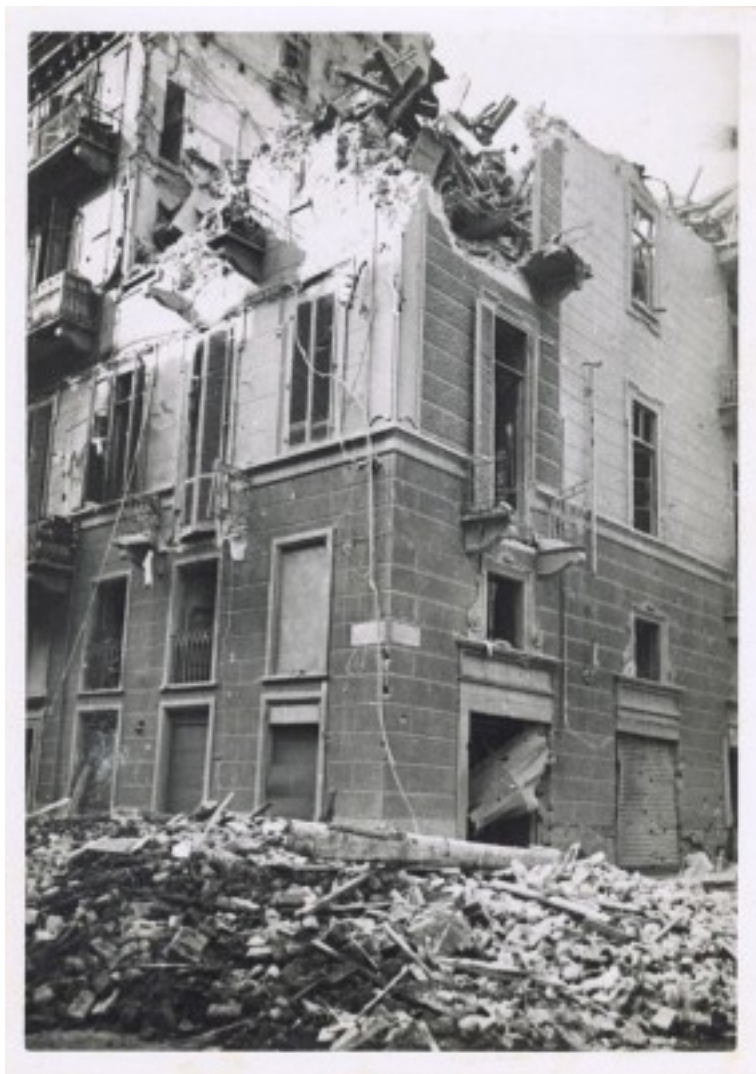
Fig. 3 Via Maria Vittoria, Via San Massimo. Effetti prodotti dai bombardamenti dell'incursione aerea del 22-23 ottobre 1942 in Via Maria Vittoria ang. Via San Massimo: "Vista dallo spigolo colpito". (ASCT, UPA 1402D_9A04-51)
