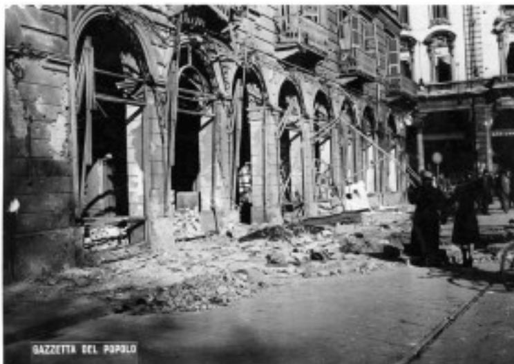
Fig. 7 Piazza Solferino. Effetti prodotti da una bomba dirompente di medio calibro caduta durante l'incursione aerea del 20-21 novembre 1942. (ASCT, UPA 1762_9A06-60.)
