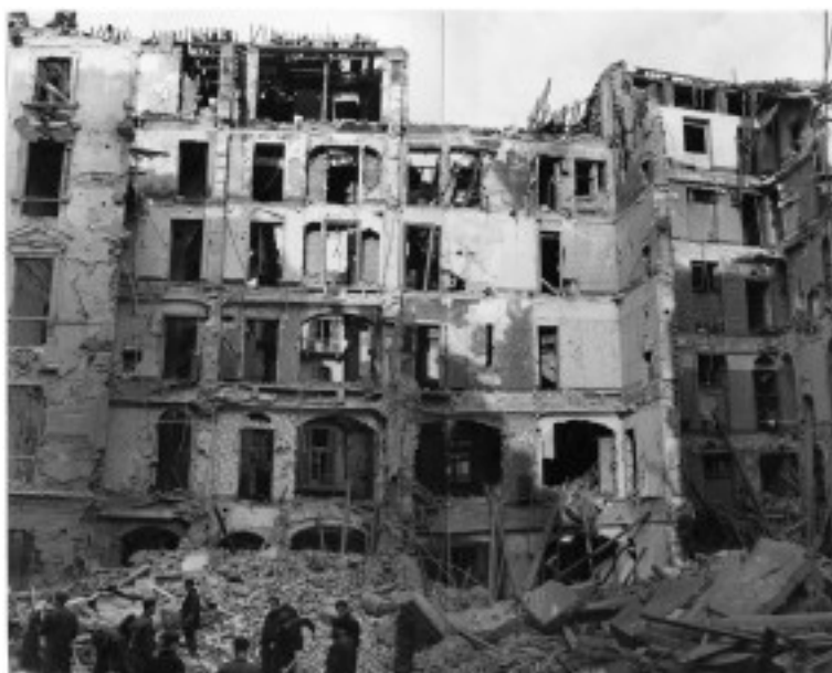
Fig. 34 Via San Quintino. Lo scheletro degli edifici a seguito degli incendi provo- cati bombardamenti dell'incursione aerea del 4-5 febbraio 1943. (ASCT, UPA 3321_9F02_73.)
