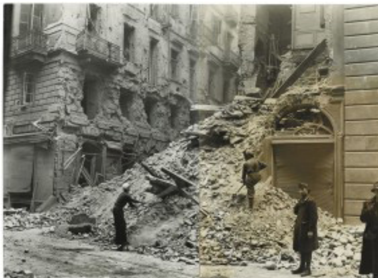
Fig. 29 Via Santa Teresa n. 20 angolo Via San Tommaso. Vigili del Fuoco al lavoro per sgomberare le macerie dopo l'in- cursione aerea del 9 dicembre 1942. (ASCT, UPA 3052_9F02_5)
