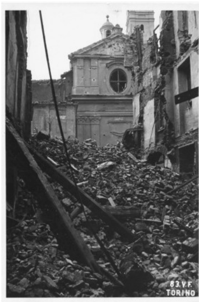
Fig. 37 Via Porta Palatina, Chiesa dello Spirito Santo. Effetti prodotti dai bombar- damenti dell'incursione aerea del 13 luglio 1943. (ASCT, UPA 3604_9D06-50)
