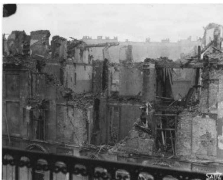
Fig. 26 Via Po n. 24. Edificio colpito dai bombardamenti dell'incursione aerea dell'8-9 dicembre 1942. (ASCT, UPA 3062_9D03-17)
