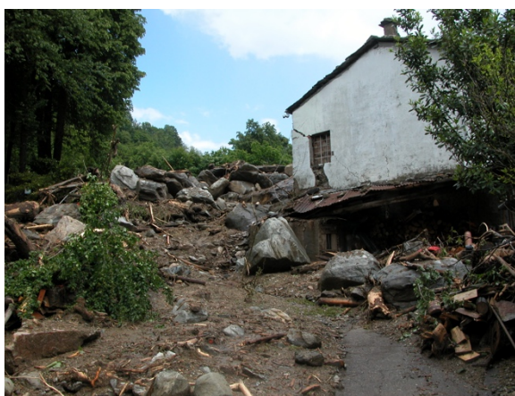
Fig. 13 – I danni provocati dall'alluvione del 2008 (AFPT – archivio fotografico Provincia di Torino)
