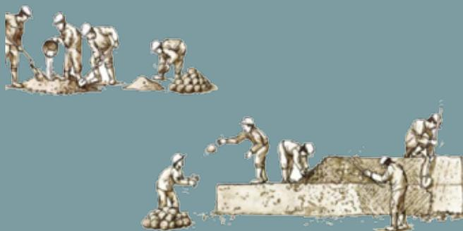
[3.0] Tecnica Bauge, fonte: APPUNTI E SLIDE DELLA LEZIONE 14\_ "LA TERRA CRUDA"
