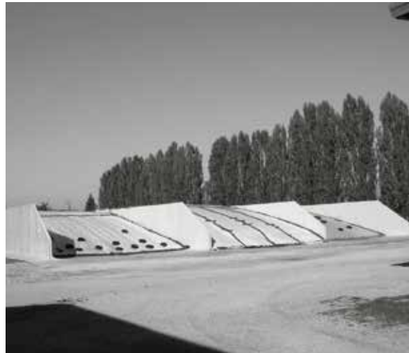
Fig. 3.8 Stoccaggio in trincee (Fonte immagine: http://www.dallamoraprefabbricati.it/agrozootecnia/muri-contenimento/ ).
