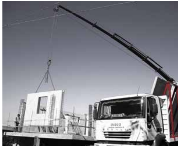
Fig. 1.3 Posizionamento della parete "S32 Modul 5".
