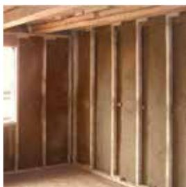
Per il supporto dell'isolamento interno delle pareti esterne sono stati posti in opera listelli di dimensione 4x6 cm a distanza di 37,5 o 50 cm. Listelli di 2,4x4,8 cm sono stati impiegati in copertura come base per il manto in tegole e per mantenere in posizione i teli anti-vento.
