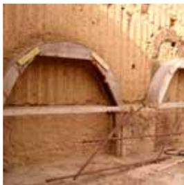
**CANNE:** Un incannucciato, legato con cordino vegetale o con ferro zincato e trattato con antiparassitari, è stato utilizzato per la realizzazione dell'impalcato nelle coperture a sostegno del manto in coppi (1858 m<sup>2</sup>), intelaiato su una struttura in legno e canne maestre. Durante la pausa dei lavori, l'esposizione agli agenti atmosferici ha deteriorato l'incannucciato precedentemente posato, rendendone necessaria la sostituzione.
