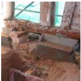
▶ **CEMENTO:** Sono state realizzate piastre di fondazione in cemento armato con altezza 20 cm, fondazioni continue e sono state rinforzate le fondazioni dal lato esterno.
