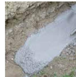
**CONGLOMERATO CEMENTIZIO:** Usato come riempimento dello scavo che circonda il perimetro dell'edificio e nei massetti delle scale e dei solai contro terra degli ambienti interni.
