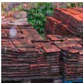
**TEGOLE:** circa il 70% delle tegole esistenti in mattoni piatti (a "coda di castoro") della falda superiore a est (45,4 m<sup>2</sup>) e circa il 30 % di quelle nelle restanti parti di copertura (57,4 m<sup>2</sup>) sono state riutilizzate per le parti del tetto meno visibili, pulite e integrate con tegole di nuove (153,6 m<sup>2</sup>), montate su una struttura di listelli in legno per garantire la ventilazione..
