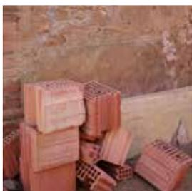
Blocchi laterizi con incastro verticale (25x25x30 cm), dalle elevate prestazioni meccaniche, termoisolanti e resistenti al fuoco, sono stati impiegati per la realizzazione delle pareti esterne dei servizi igienici G e dei locali di servizio H (77,7 m<sup>2</sup>).
