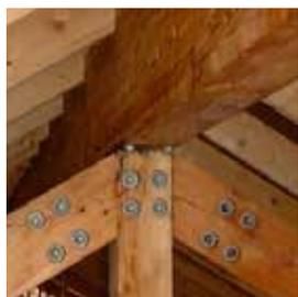
**LEGNO:** Per realizzare la struttura della copertura e del telaio dei tamponamenti, è stato utilizzato legno di larice di origine locale, in forma lamellare, considerata più efficiente (vi è però l'utilizzo di colle adesive non ecologiche).
