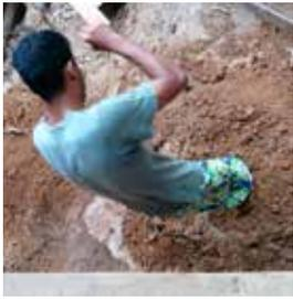
▶ **TERRA:** 15 tonnellate di terra sono state prelevate dagli scavi e dai vari spianamenti e livellamenti. È stata utilizzata senza addizioni nella realizzazione del riempimento delle pareti, e unita a sabbia e calce nella realizzazione degli intonaci.
