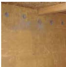
Pannelli OSB dello spessore di 22 mm sono stati utilizzati nei solai (129,69 m<sup>2</sup>) e per le capriate (110,630 m<sup>2</sup>), nelle coperture di spessore 15 mm (40,26 m<sup>2</sup>) e di 18 mm (25,21 m<sup>2</sup>).
