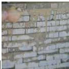
**MATTONI IN TERRA CRUDA:** prodotti dalla fornace Carulli di Picciano (PE), caratterizzati da un'alta presenza di argilla (è stato utilizzato il cappellaccio, la terra sporca, per la loro realizzazione) e alleggeriti con segatura.
