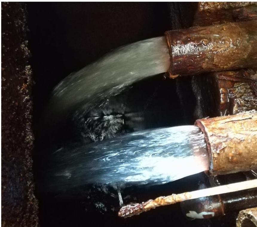
*Fig. 5.2.1 – Tubi di immissione dell'acqua dai pozzi alla vasca di ossidazione, in alto abbiamo il tubo proveniente dal pozzo 2 ed in basso quello del pozzo 1-3.*
