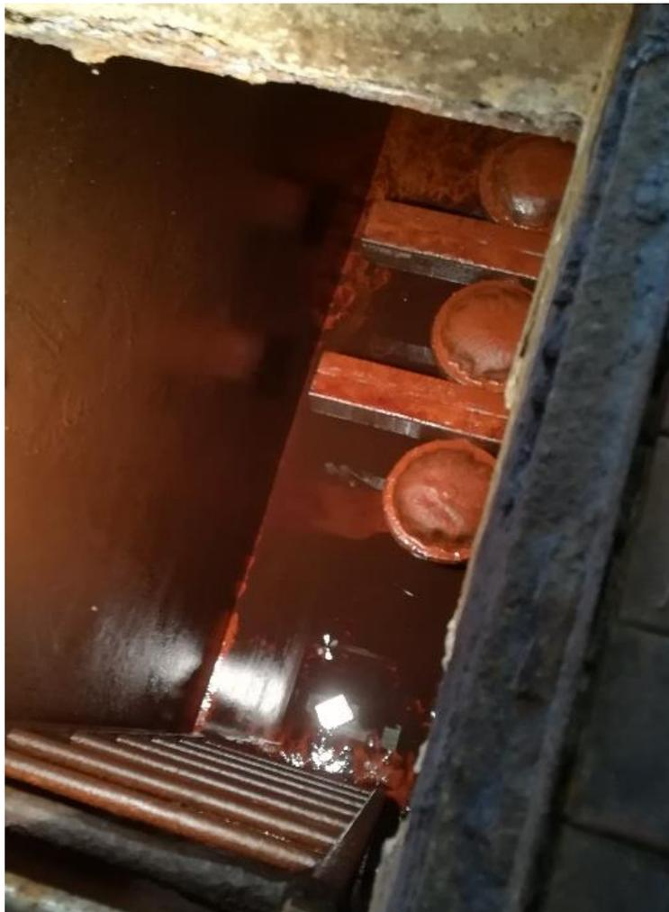
*Fig. 5.3.5 – Foto della vasca di aerazione una volta svuotata, prima dello spurgo*
