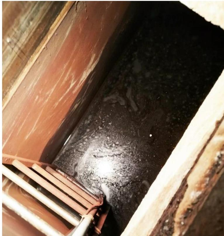
*Fig. 5.4.3 – Spurgo della seconda vasca di sedimentazione*
