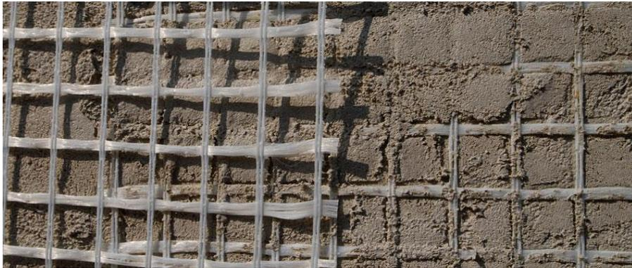
**Figura 3.8** - Esempio di applicazione delle reti in fibra di vetro alla malta cementizia
