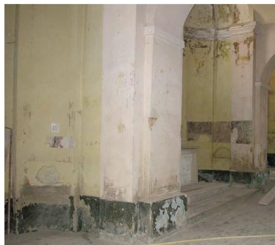
Fig 2. Particolare dello stato di degrado dei paramenti murari
