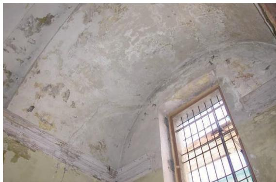
*Fig 4. Degrado delle volta in corrispondenza del transetto: lato Via Carducci.*
