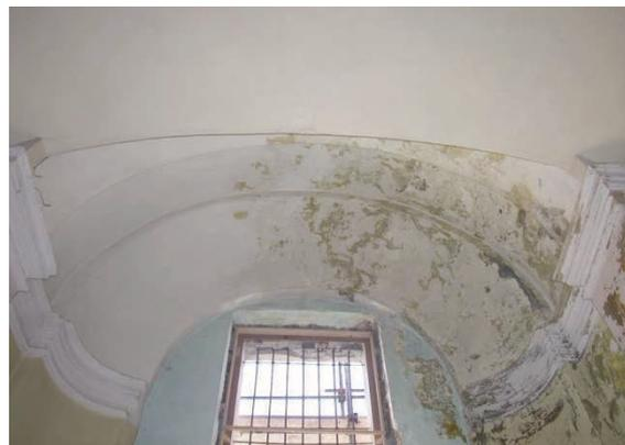
Fig 3. Degrado delle volte in corrispondenza delle cappelle laterali
