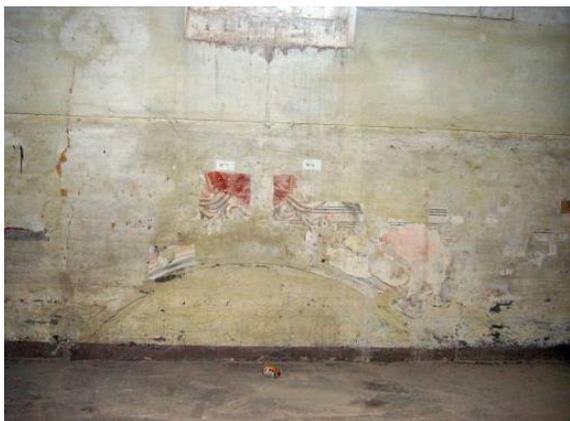
**Fig 12.** Arco della cappella a livello inferiore della Chiesa tamponato durante la costruzione del solaio di divisione
