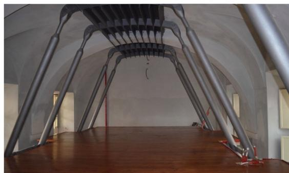
**Fig 18.** Struttura metallica inserita per il sostegno della volta nella manica est del complesso
