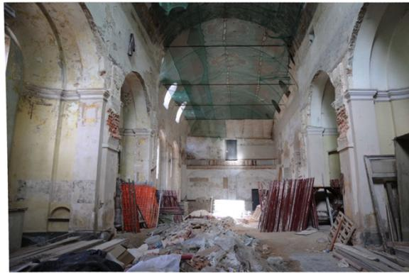
*Fig 26. Demolizione del solaio intermedio.*
