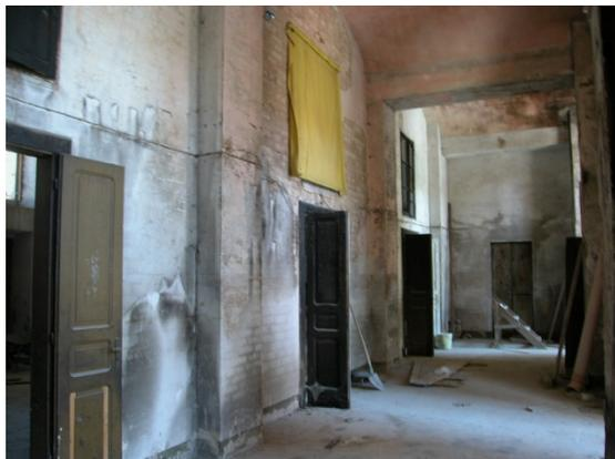
**Fig 13.** Nell'immagine i due ambienti ottenuti mediante la divisione dell'originaria aula con un setto parallelo al portico.
