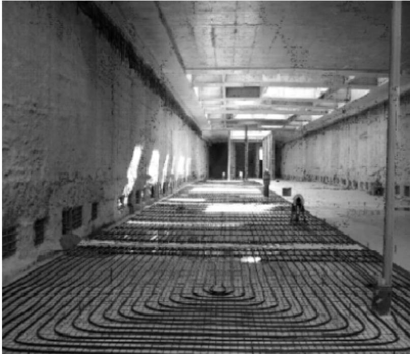
Figura 2.6. Piastra di fondazione equipaggiata con tubi scambiatori di calore presso la stazione "Messe" U2 – Vienna (Adam e Markiewicz, 2009)
