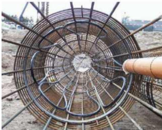
Figura 2.4. Particolare di tubi scambiatori di calore fissati alla gabbia di armatura di un palo energetico di fondazione a largo diametro (Brandl, 2006)
