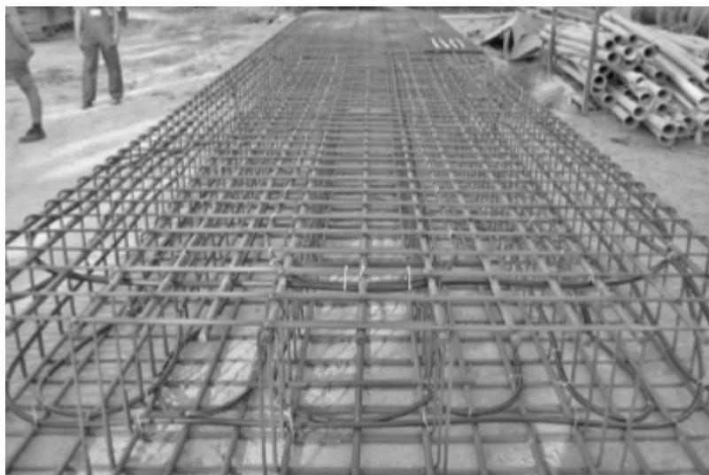
Figura 2.5. Particolare di armatura di un diaframma energetico e relativo circuito di tubazioni di scambio di calore (Brandl, 2006)
