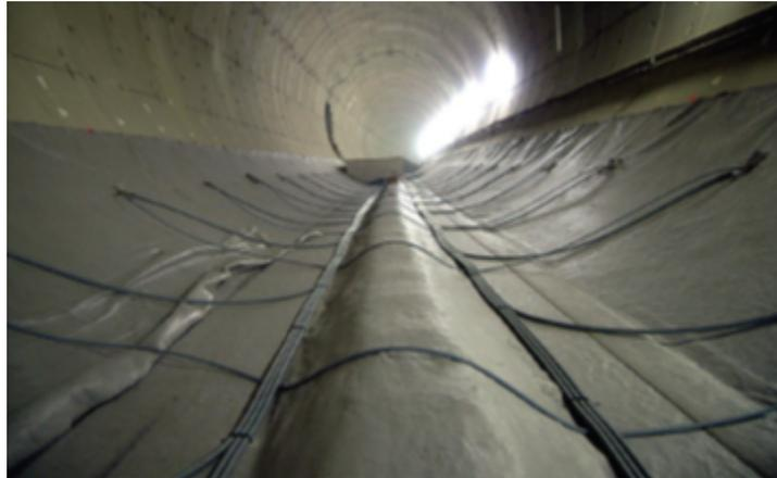
Figura 2.16. Tubazioni del circuito di scambio termico installate in corrispondenza della base della galleria (Jenbach – Austria) (Franzius e Pralle, 2011)
