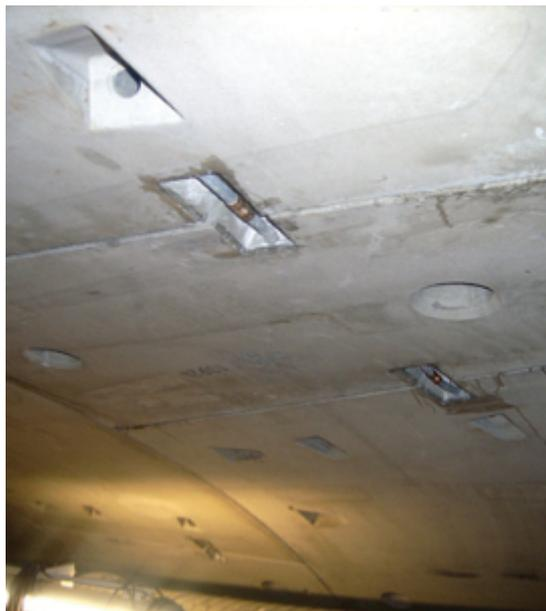
Figura 2.14. Rivestimento prefabbricato installato - Dettaglio dei collegamenti idraulici tra i conci energetici tramite tasche di accoppiamento (Franzius e Pralle, 2011)
