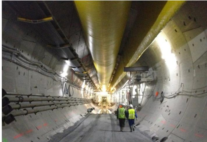
Figura 2-4: Fase di scavo con la TBM del secondo tunnel
