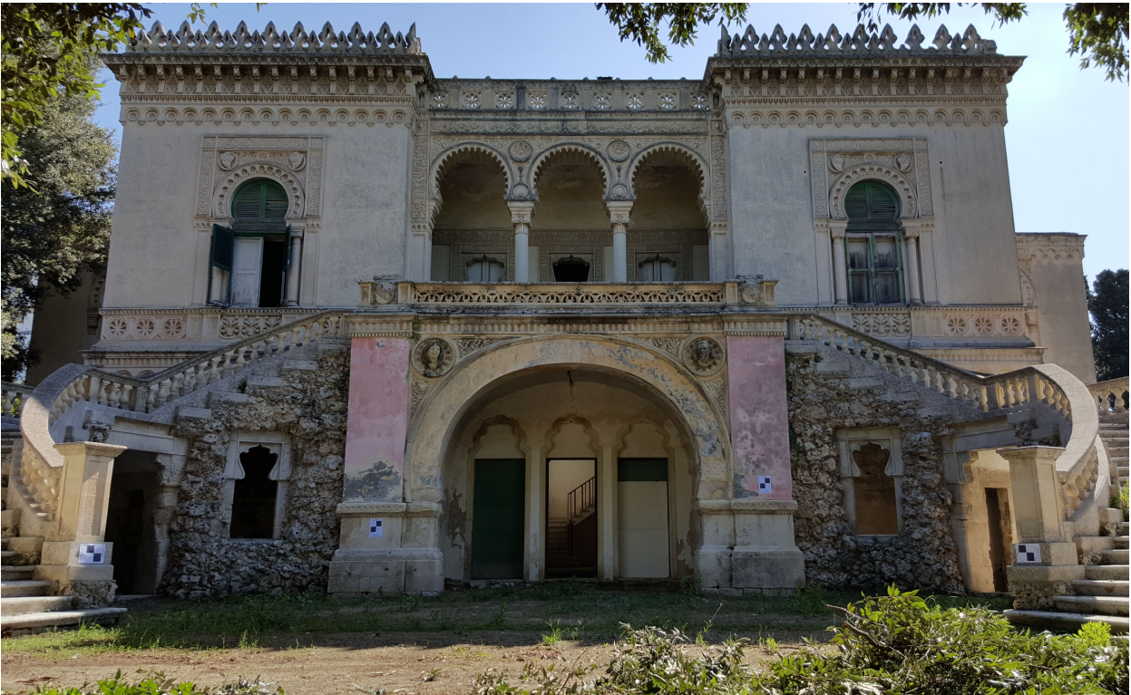
Foto1. Il prospetto principale di Villa Himerà oggi
