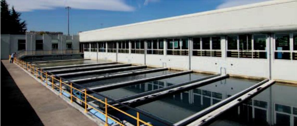
Figura 2.23 – Filtri a carbone attivo granulare (Fonte: <http://www.smatorino.it>)
