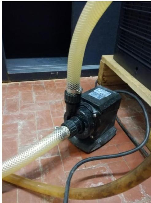
Figura 6.38 – Pompa idraulica *WILTEC 50966* utilizzata per il ricircolo dell'acqua dell'impianto di raffreddamento
