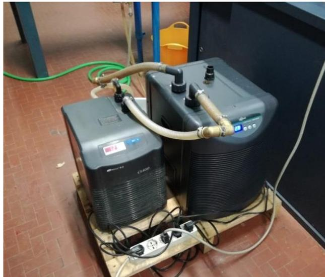
Figura 7.1 – I due chiller dell'impianto di raffreddamento. Sullo sfondo la gomma verde utilizzata per riempire il serbatoio di raffreddamento con acqua della rete idrica
