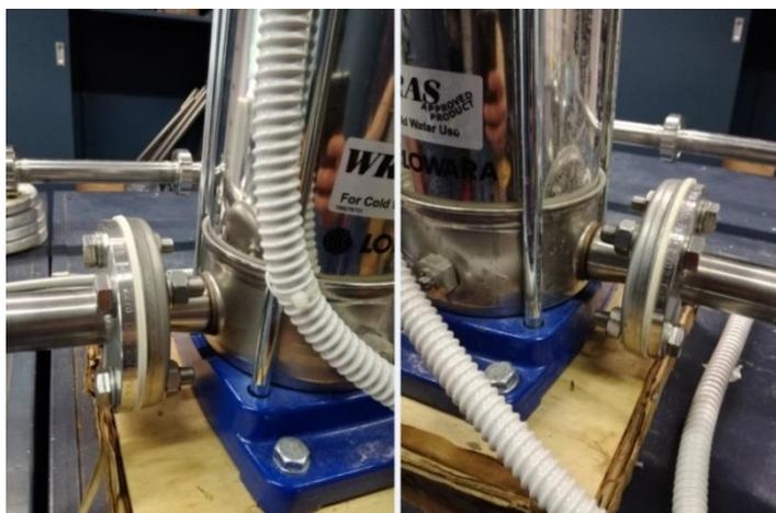
Figura 6.17 – Particolare dei collegamenti della pompa all'impianto, a monte (a sinistra) e a valle (a destra)
