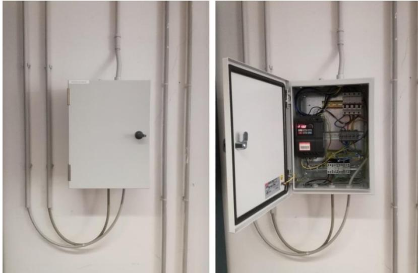
Figura 6.18 – Inverter dell'impianto di cavitazione idrodinamica; modificando la frequenza di rotazione della girante idraulica della pompa (nella fotografia impostata a 10 Hz) è possibile indurre all'interno dell'impianto portate e pressioni differenti
