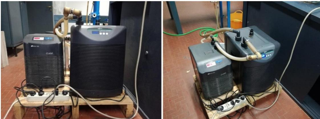
Figura 6.35 – I due chiller utilizzati nell'impianto di raffreddamento. A destra è visibile in collegamento in serie tra i due apparecchi.
