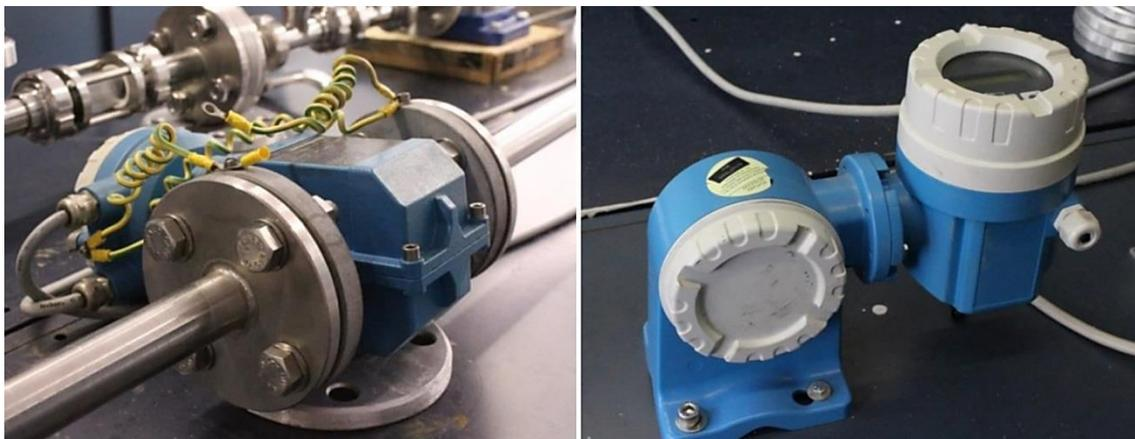
Figura 6.24 – Misuratore di portata installato all'interno dell'impianto (a sinistra) e display di visualizzazione della portata fluente (a destra).
