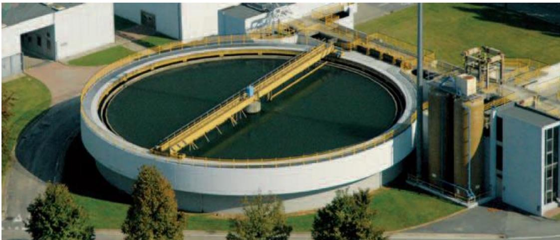
Figura 2.20 – Predecantatore statico e silos di stoccaggio del carbone attivo (Fonte: <http://www.smatorino.it>)
