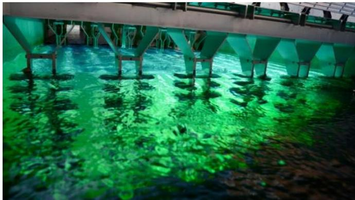
Figura 2.24 – Trattamento di disinfezione dell'acqua mediante radiazioni UV (Garofano, 2016)
