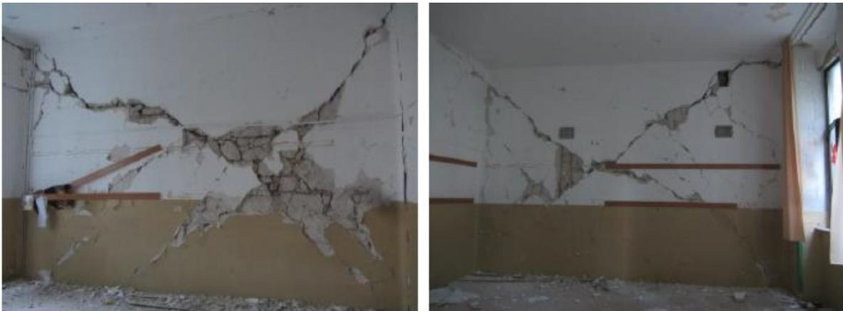
Figura 3-18 Lesioni a taglio per fessurazione diagonale nei maschi del piano terra in direzione Y
