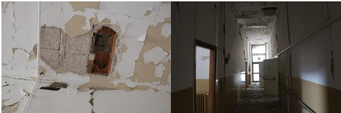
**Figura 3-17** Lesioni osservate nel corridoio del primo piano: a sinistra si osserva un distacco del controsoffitto con crollo locale del laterizio del solaio del piano superiore, a destra una vista longitudinale del corridoio
