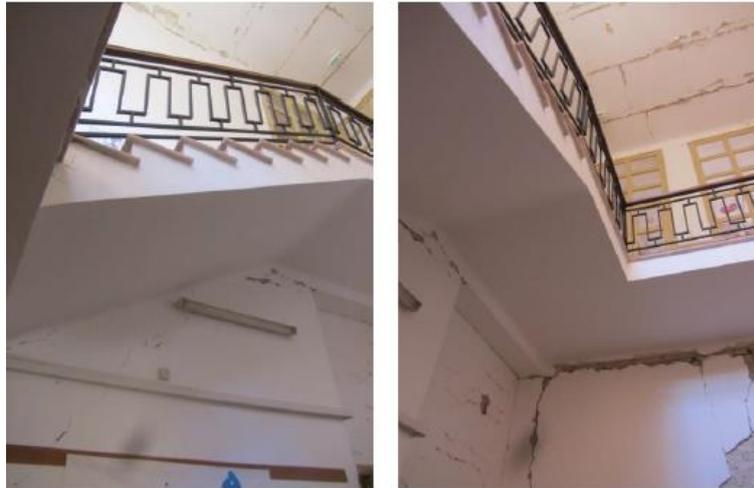
Figura 3-20 Dettagli delle lesioni nel corpo scala
