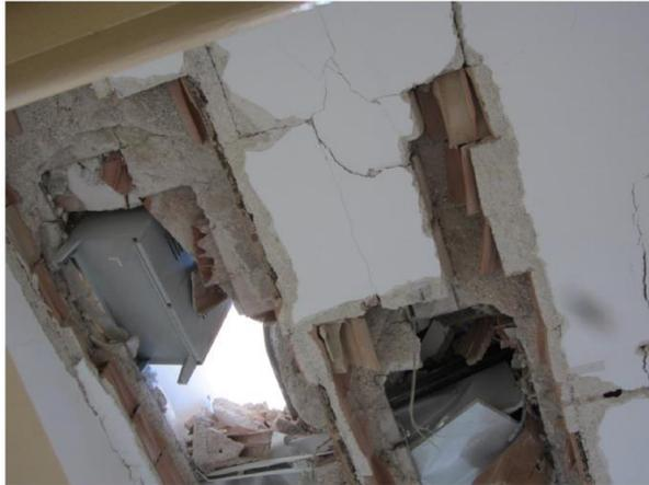
**Figura 3-21** Crollo del solaio di calpestio del primo piano
