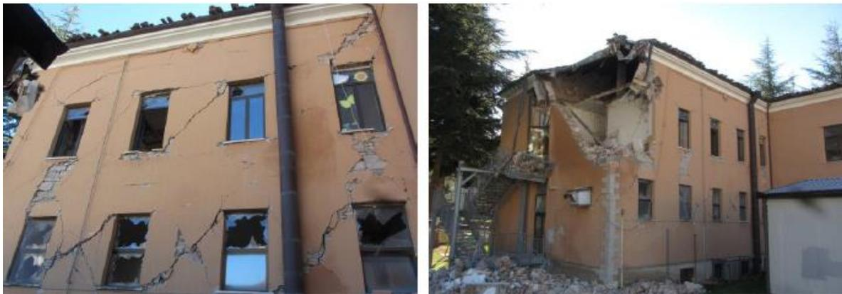
**Figura 3-14 Stato di danneggiamento esterno dopo gli eventi di Ottobre 2016**
