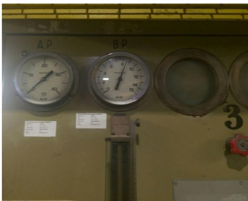
Figura 4.4 – Indicatori di pressione del compressore
