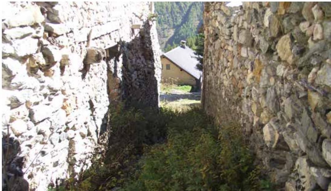
FOTO 129 ► Esempio di setto murario da consolidare
