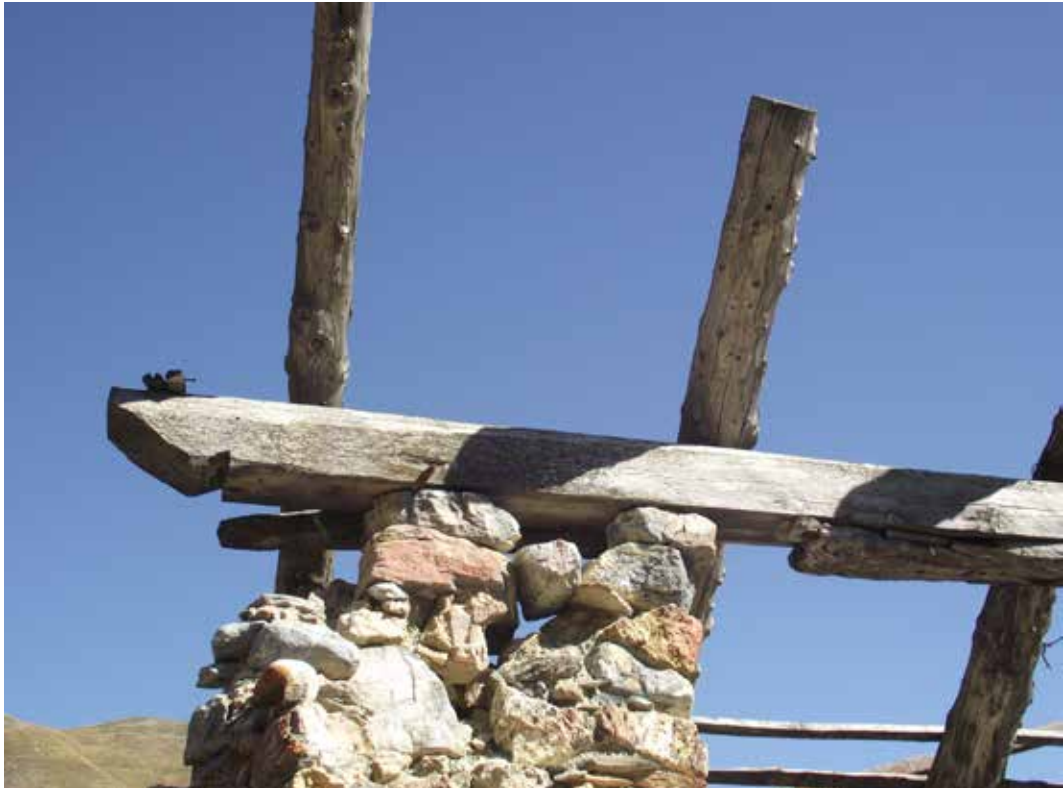
FOTO 121 ▾ particolare di un'orditura ligna di copertura
