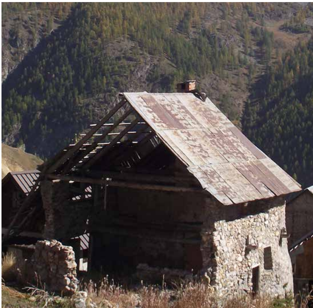
FOTO 111 ◀ Il tipico impianto di copertura con inclinazione 45°
