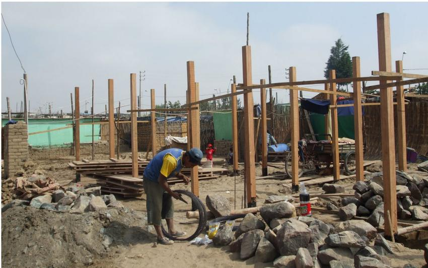
Figura 1.30 "Palificazione" con elementi verticali lignei
