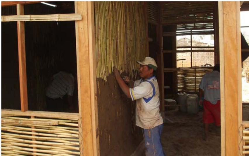
Figura 1.32 Stesura del rivestimento in fango e paglia
