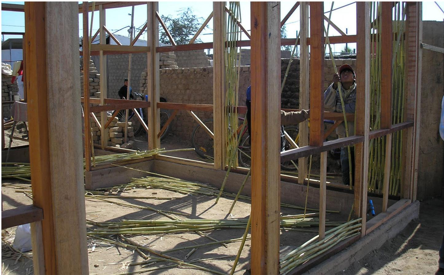
Figura 1.31 Creazione dell'intelaiatura in canne
