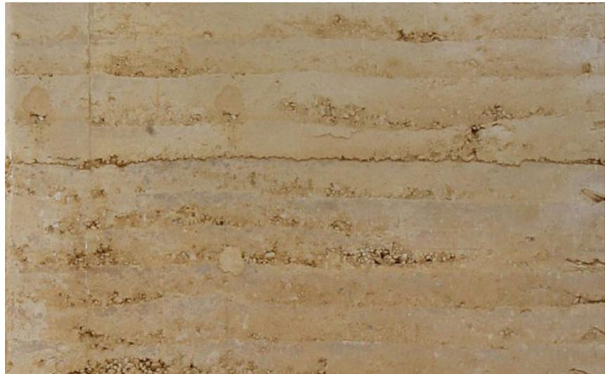
Figura 1.24 Tecnologia costruttiva autoctona: *Tapial*
