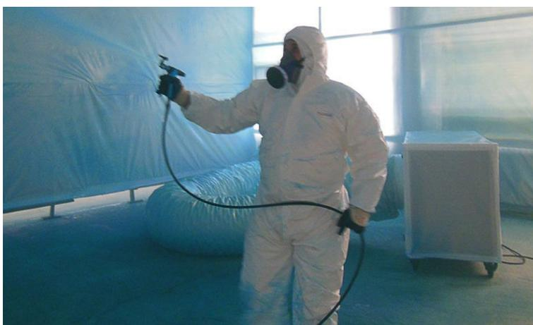
permettano di separare le superfici contenenti amianto dalle restanti aree dell'edificio, impedendo così la liberazione delle fibre nelle zone occupate da individui. È un a buona tecnica se necessario delimitare piccole aree di intervento entro le quali non è richiesto accedere di frequente.
