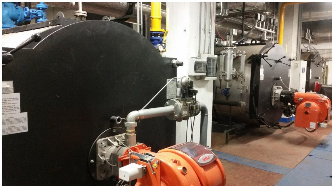
Figura 3.3.1 Foto delle caldaie a gas metano nella centrale termica
