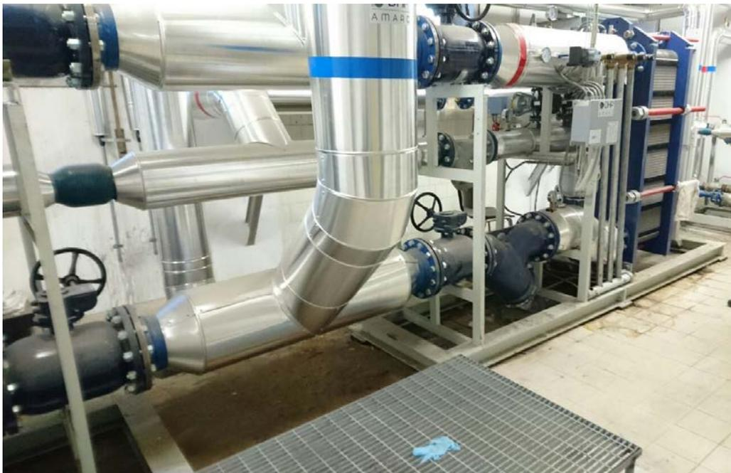
*Figure 3.3.2 Scambiatore primario con la rete del teleriscaldamento*
