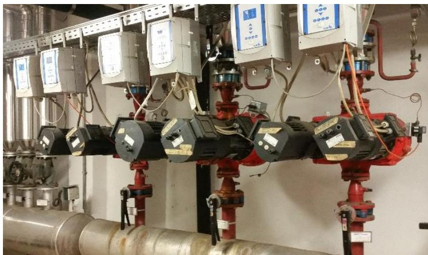
*Figura 8 Pompe con inverter*
