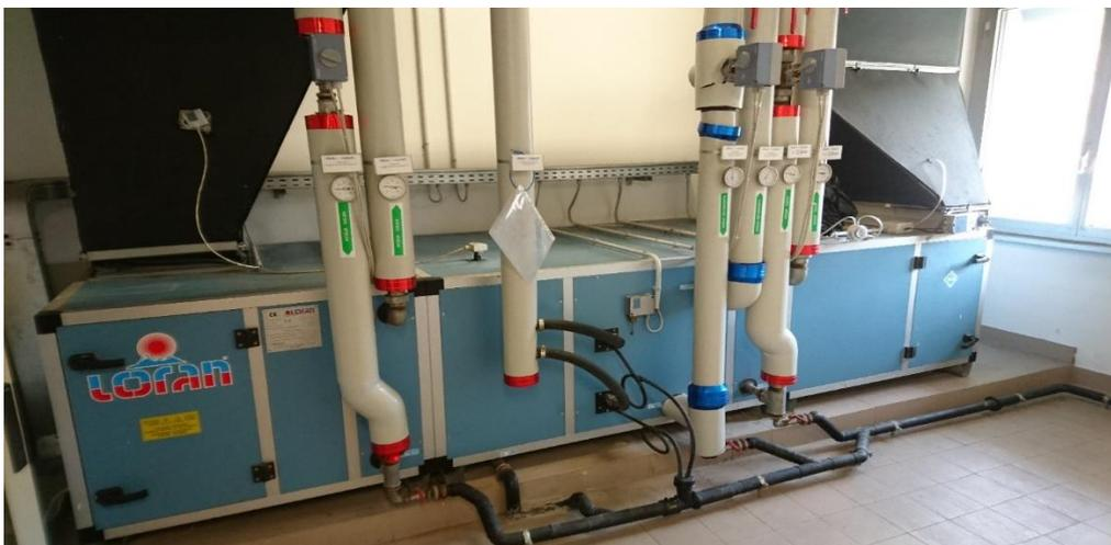
Figura 27 Unità di trattamento aria, piano 3 zona B
