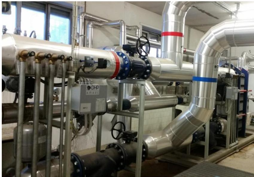
Figura 2.3-1 – Stazione teleriscaldamento, Centrale termica principale P.O. Martini
