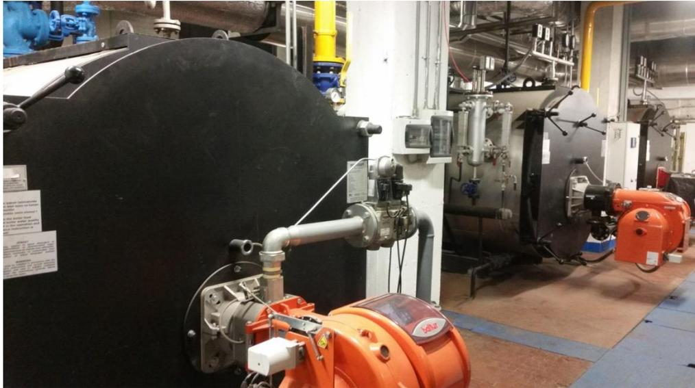
Figura 2.3-2 – Generatori a vapore, centrale termica principale P.O. Martini
