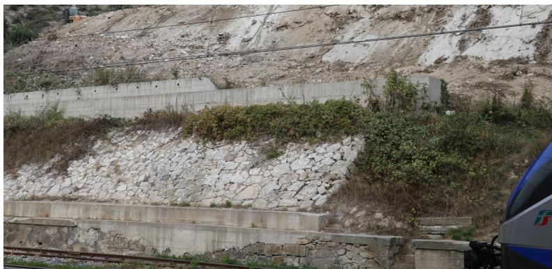
Figura 3.6: Cordolo di micropali intirantati al livello 1 - Foto del 04.10.2017
