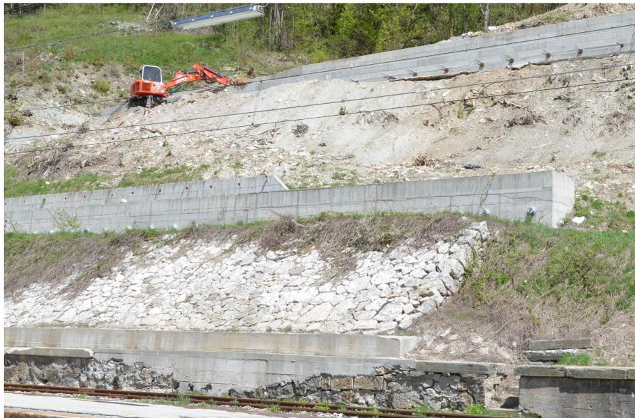
Figura 3.2: Muro a secco per il contenimento del corpo di frana - Foto del 30.04.2018
