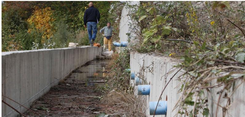
Figura 3.7: Fila di dreni in corrispondenza del livello 1 - Foto del 04.10.2017
