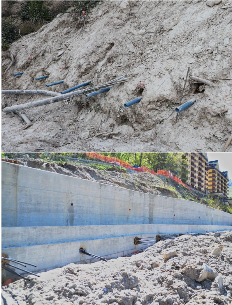
Figura 5.8: Cordolo del livello di monte e relativa batteria di microdreni
