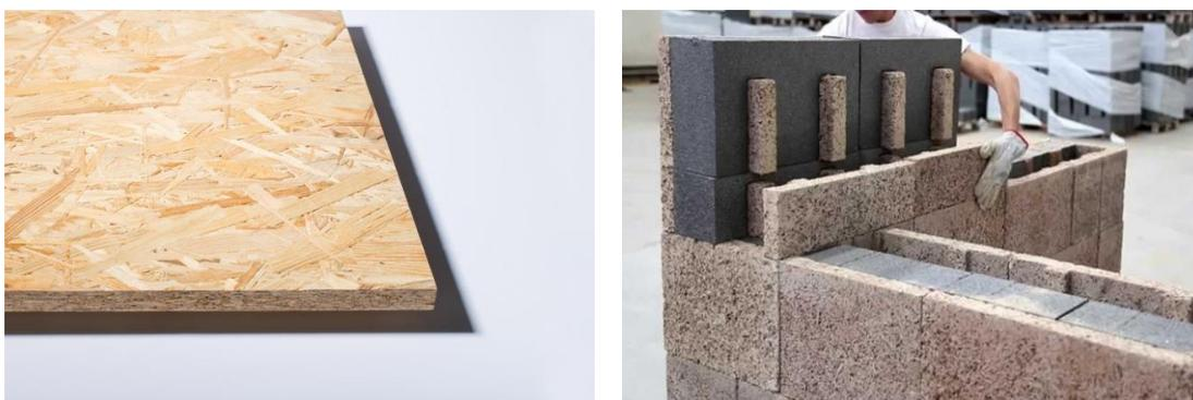
*Figura 4: Pannello OSB a sinistra e posa di una muratura in blocchi di legno-cemento ( Fonte: Google Images, Isotex )*
