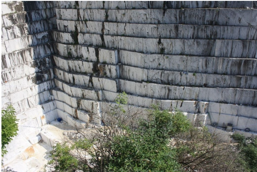
Figura 10 – Parete Sud prima dell'inizio dello scavo in sotterraneo
