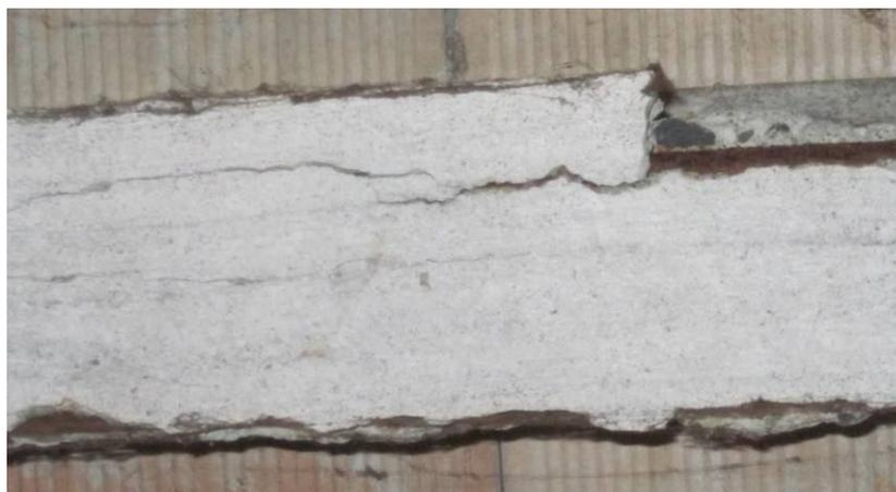
**Fig.2.10.3 Fessurazione longitudinale e distacco del copriferro in una trave soggetta a corrosione**
