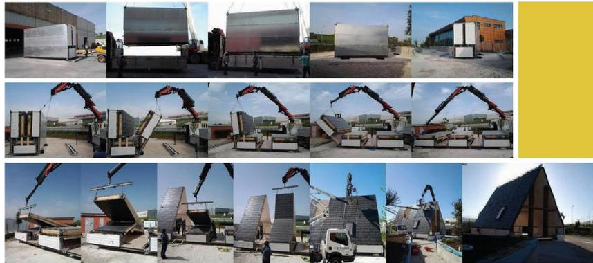
*Figura 5-7 : Schema costruttivo M.A.D.I. Home*
