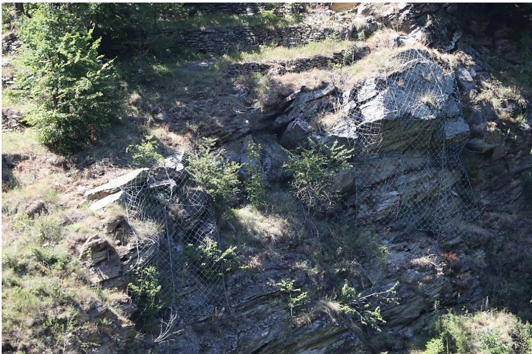
Figura 28 – Zona del ciglio aggettante con rete in aderenza; si può notare l'assenza di raccordo tra i due pannelli di rete posizionati che ricoprono solamente le zone più strapiombanti
