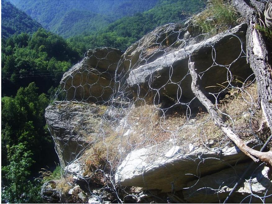
Figura 30 – Esempio di rete ad anelli in esercizio sul versante oggetto di studio; si può osservare il mutuo intreccio delle maglie
