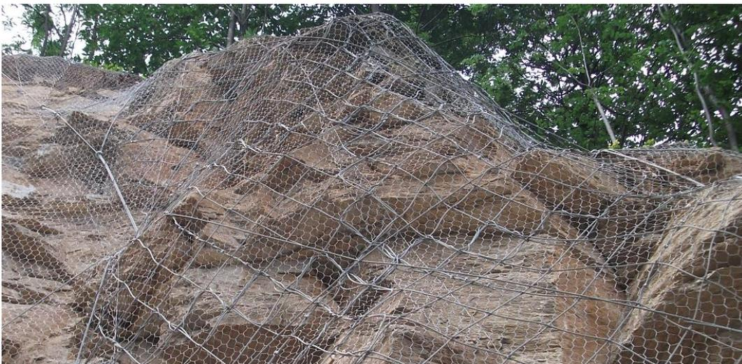
Figura 31 – Esempio di rete a pannelli di fune posta in esercizio, in questo caso specifico rete a doppia torsione più funi di contenimento (ediltecnoervice.com)
