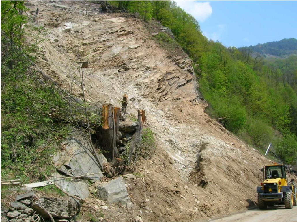
Figura 13 – Versante oggetto di studio a seguito del dissesto del 2011; è possibile osservare materiale detritico distaccatosi, riposizionato durante i lavori di emergenza
