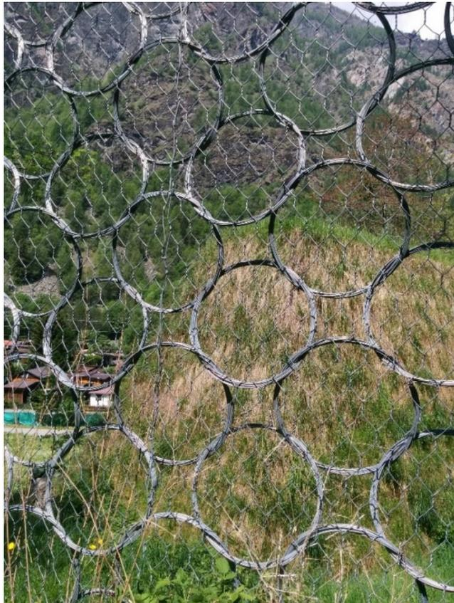
Figura 37 – Struttura di intercettazione di barriera paramassi deformabile, costituita da rete ad anelli più rete a doppia torsione
