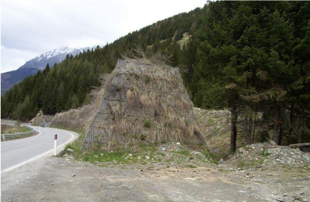
Figura 35 - Rilevato paramassi in terra rinforzata, sono ben visibili gli strati all'interno del rilevato e la copertura dello stesso di geosintetico (arpalombardia.it)
