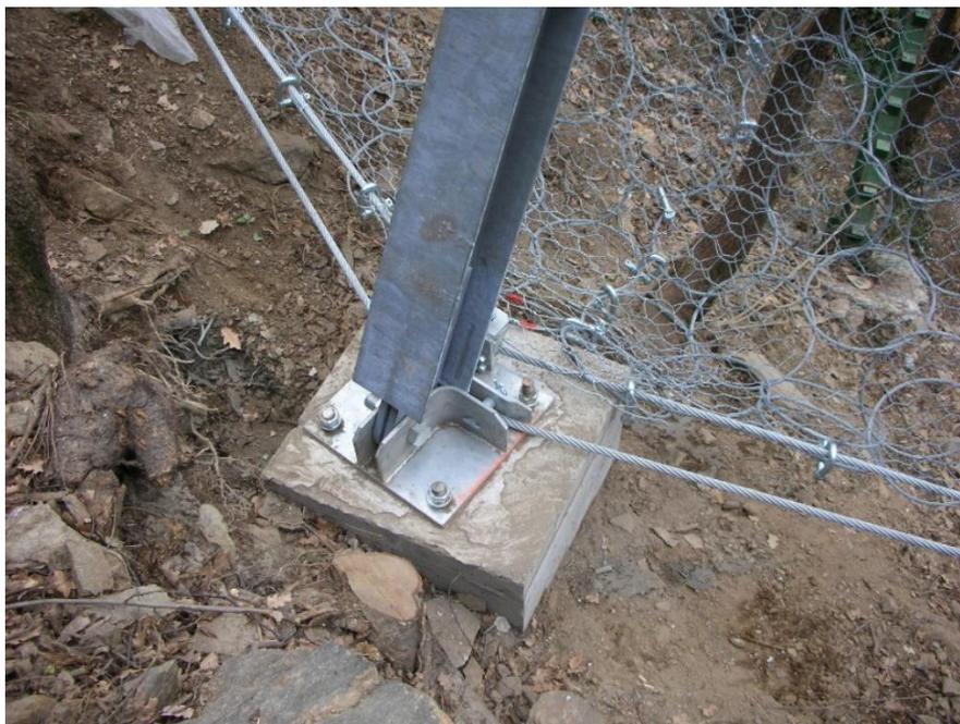
Figura 38 – Esempio di montante di barriera paramassi, con collegamento all’ancoraggio al suolo (consolrocce.com)
