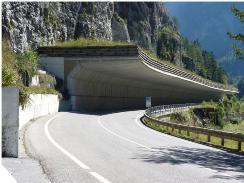
Figura 39 – Esempio di galleria paramassi per protezione dalla caduta di materiale di piccole o modeste dimensioni; si può osservare la totale assenza di colonne di sostegno nella zona di valle e la presenza di coltre detritica di dissipazione nella parte sommitale (“Ponte del Cristo Agordo” (BL); isolarben.it)
