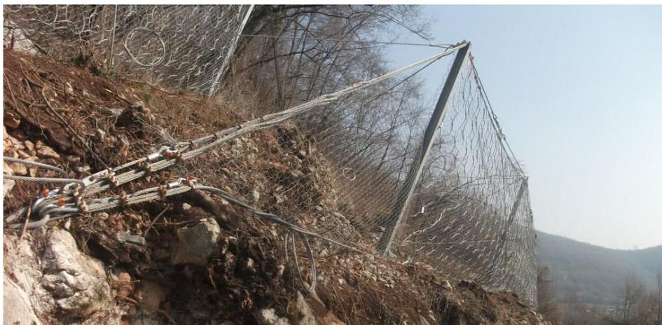
Figura 36 – Esempio di barriera paramassi deformabile in esercizio, sono visibili in primo piano le funi fissate con morsetti all'ancoraggio della barriera; nella parte posteriore si può osservare un dissipatore (freno) della controventatura ([ediltecnoervice.com](http://ediltecnoervice.com))
