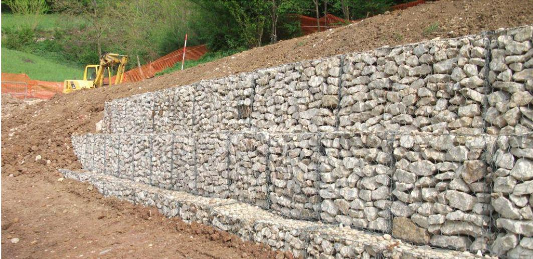
Figura 41 – Esempio di un muro a gravità a gabbioni; ben visibile il posizionamento sfalsato delle gabbie appositamente riempite con materiale roccioso uniforme, di media pezzatura, per ottenere una migliore stabilità (ediltecnoservice.com)
