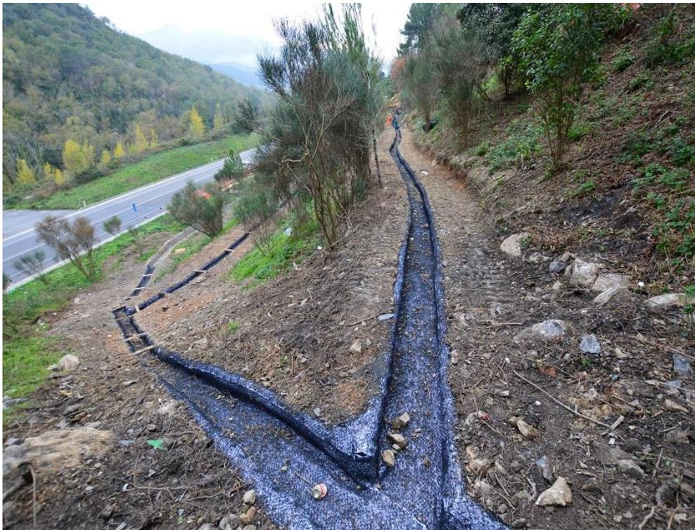
Figura 43 – Esempio di canaline ramificate per regimazione delle acque superficiali, costruite con geostuoia rivestita da pellicola impermeabile (geoprodotti.eu)
