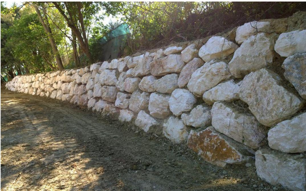
Figura 40 – Esempio di un muro a gravità a scogliera con blocchi appoggiati (accattoliscavi.it)
