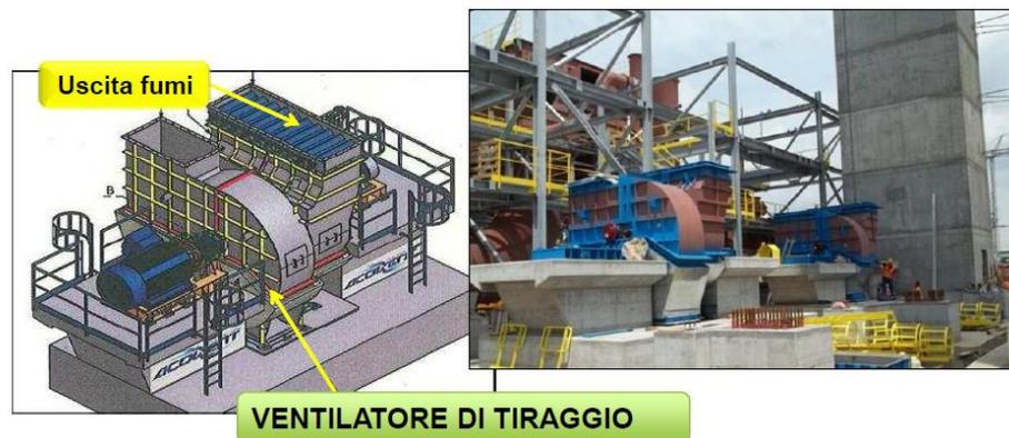
Figura 4.6. Schema illustrativo e immagine del ventilatore di tiraggio
