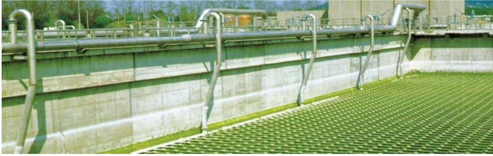
**Figura 3.5 Vasca di aerazione con disposizione di diffusori a disco.**
