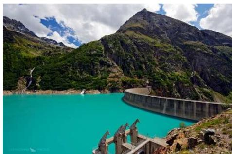
Figura 31 - Diga ad arco gravità di Place Moulin (AO)
