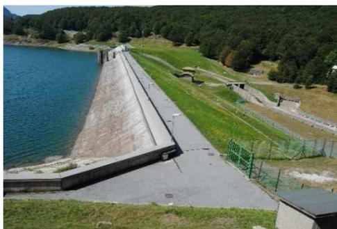
*Figura 39 - Diga di Paduli (MS) con struttura di tenuta esterna*
