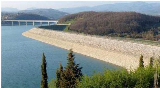
*Figura 37 - Diga in terra e pietrame di Bilancino (FI) con struttura di tenuta interna*
