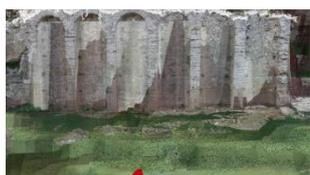
*Dettaglio di parte del muro della villa delle Logge, sito sull'acropoli di Populonia, la nuvola di punti è stata originata da fotogrammetria terrestre.*
