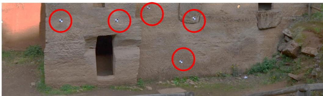
*Figura 21\_Marker terrestri applicati su una parte della parete di cava.*
